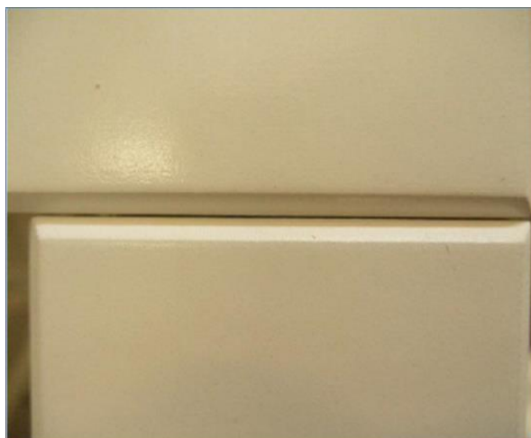
Figura 4.1 – Folga entre os elementos de ligação.
