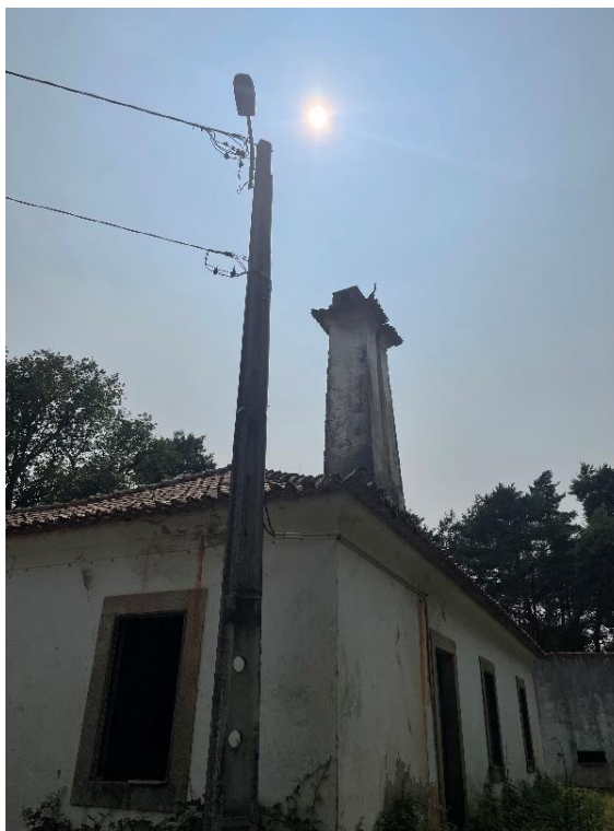
Figura 29 - Poste de Baixa tensão
