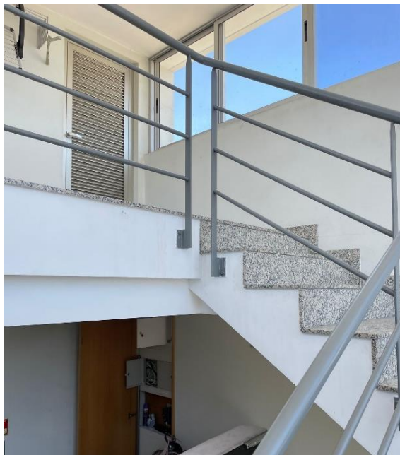
Figura 38 - Piso de acesso à cobertura
