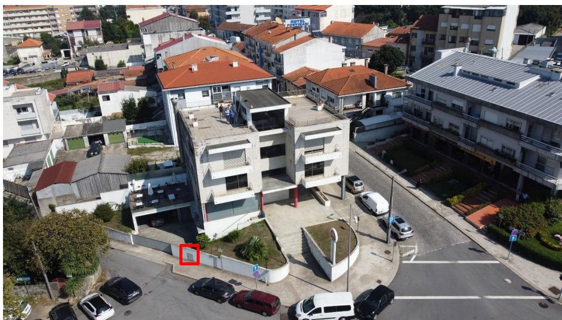
Figura 33 - Armário de distribuição e a sua alimentação
