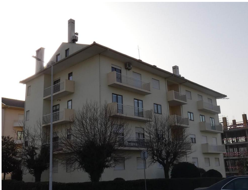
Figura 16 - Implementação em Rooftop
