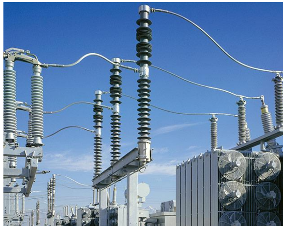
Figura 24-Trans-rupter II montado (S&C 2018)
