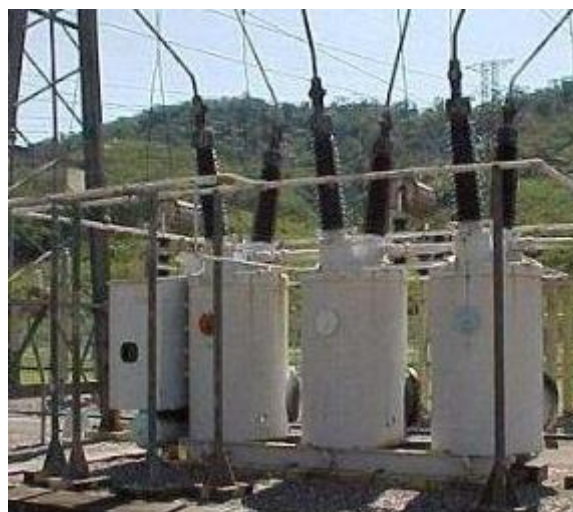
Figura 16- Disjuntores (Montenegro 2016)
