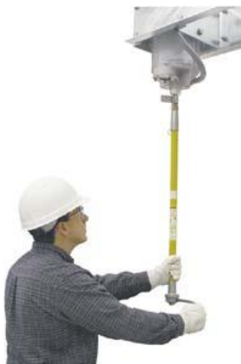
Figura 25-Fecho e carregamento do trans-rupter (S&C 2018)
