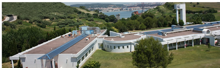
Figura 2-1 - Instalações do IPQ no Monte da Caparica. [3].
