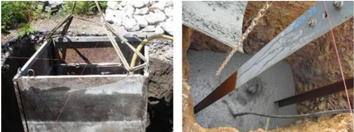
Figura 2.10 - Betonagem de apoios
