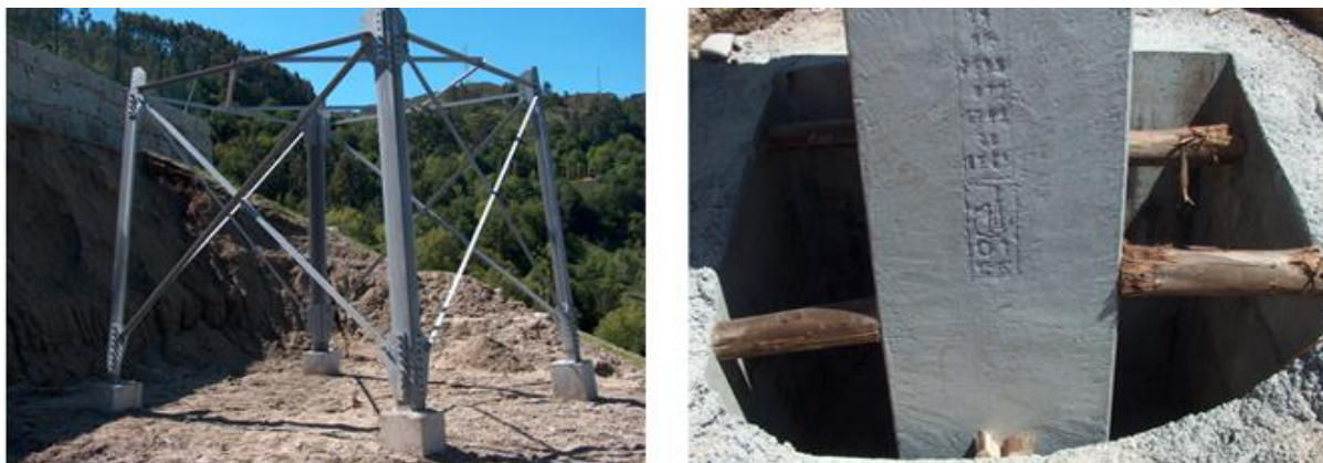
Figura 2.5 – Colocação de Apoios
