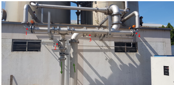
Figura 4.2 - Pontos de amostragem criados para alimentação dos analisadores
