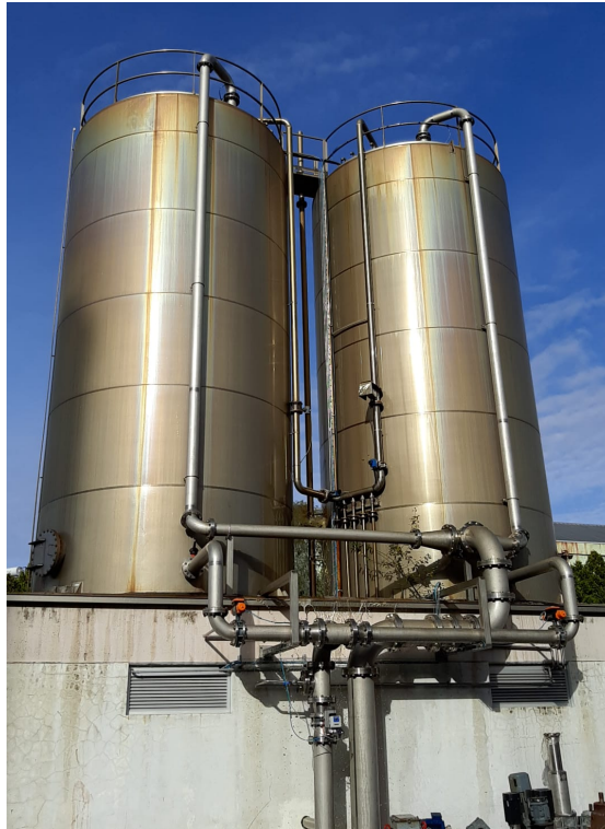
Figura 3.5 - Tanques de homogeneização
