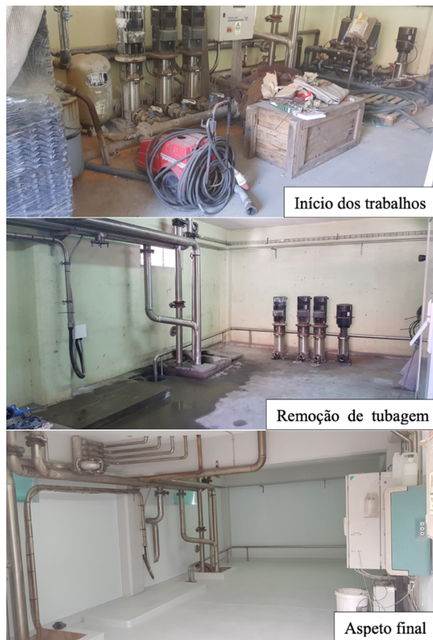
Figura 3.7 - Decorrer dos trabalhos realizados na adaptação dos tanques de homogeneização
