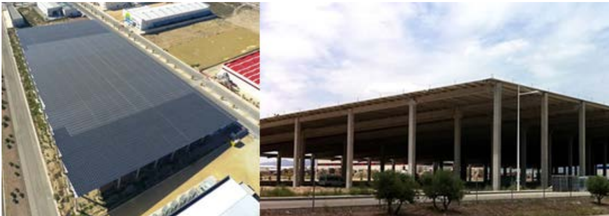
Figura 49. Cubierta Solar, Murcia [97] [104]
