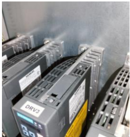
Figura 98 - Fixação dos drives .
