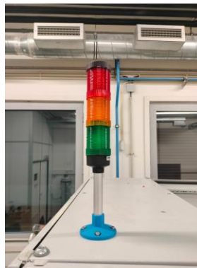
Figura 101 - Torre de sinalização.
