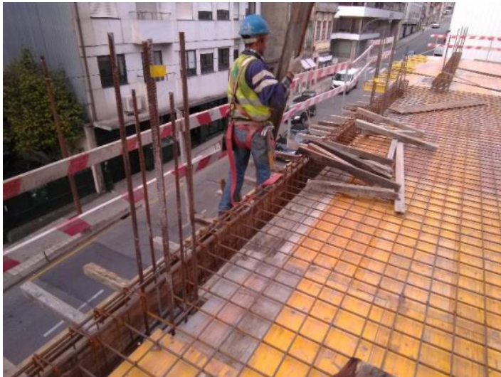
Figura 4 – Trabalhos de Cofragem Fonte de autor
