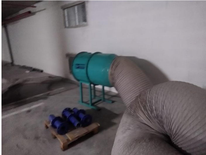
Figura 17 – Ventilador em funcionamento para trabalhos em depósito (espaço confinado)
