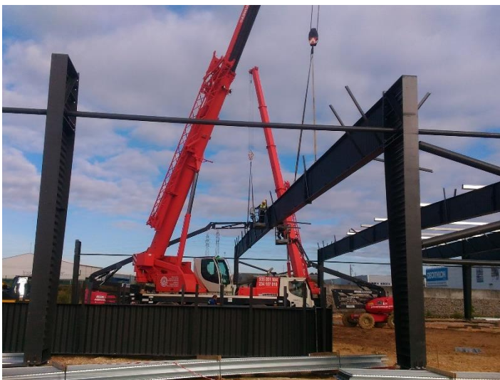
Figura 6 – Montagem de estrutura metálica com recurso a autogruas Fonte de autor
