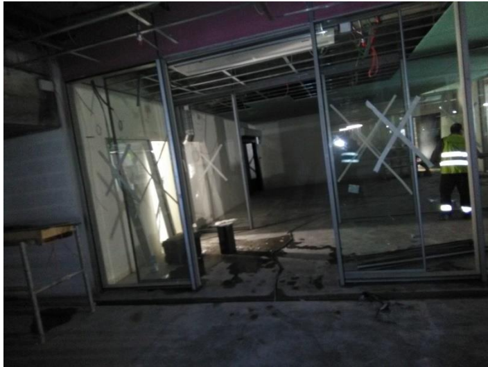
Figura 12 – Aplicação de envidraçados (antecâmara de elevadores) Fonte de autor
