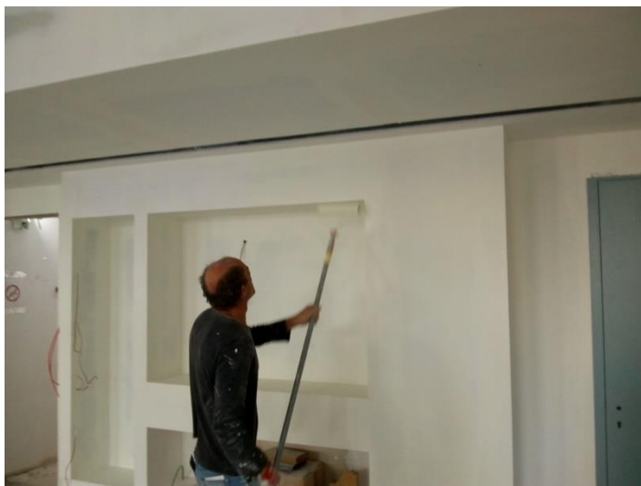
Figura 13 – Trabalhos de pinturas (trabalhador sem EPI's obrigatórios) Fonte de autor
