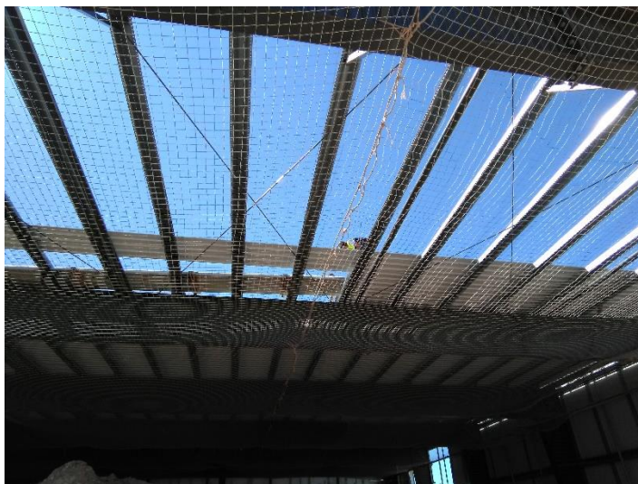
Figura 9 – Trabalhos de aplicação de chapa de cobertura com recurso a redes de segurança Fonte de autor
