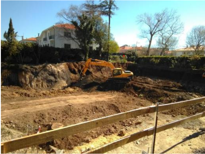
Figura 2 – Trabalhos de Escavação Fonte de autor
