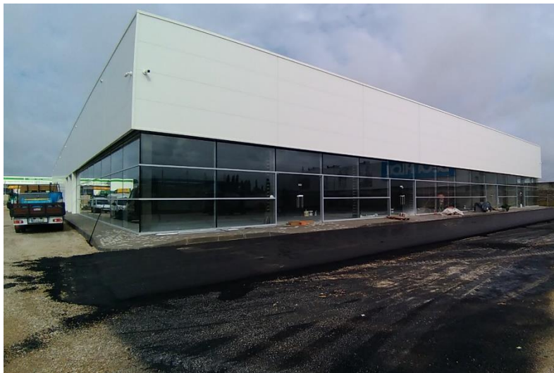
Figura 16 – Pavimentação de zona exterior Fonte de autor
