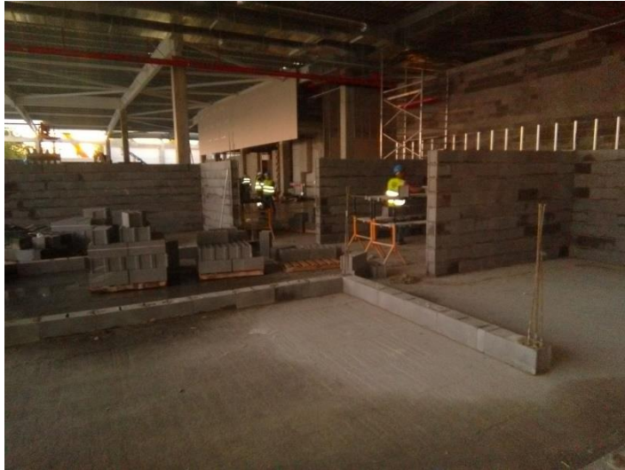
Figura 7 – Execução de alvenarias Fonte de autor
