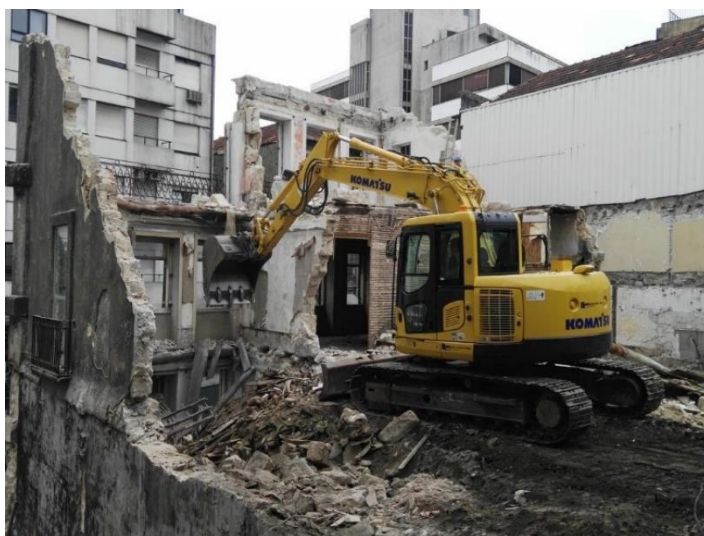
Figura 1 – Demolição de fachada de edifício existente Fonte de autor
