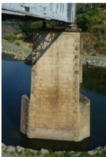
a) Pilar de alvenaria de pedra
