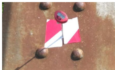
a) Termómetro que mede a temperatura da estrutura
