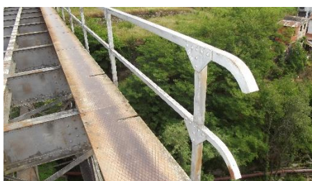
Figura 2.8 - Passeio no tabuleiro ao nível superior.
