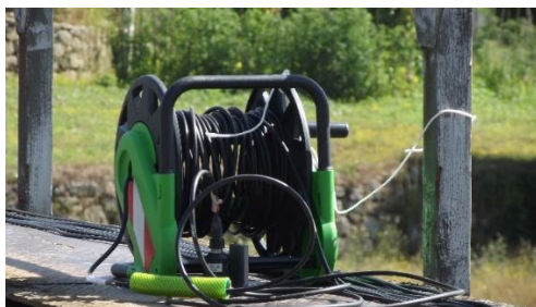
a) Pormenor da proteção da ligação entre cabos com troços de mangueira
