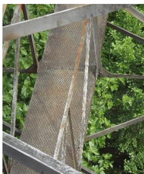
Figura 2.9 - Passadiço no nível inferior.
