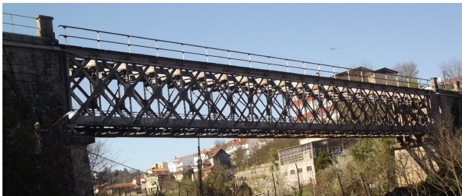
Figura 2.2 - Vista geral da ponte de S. Lázaro.
