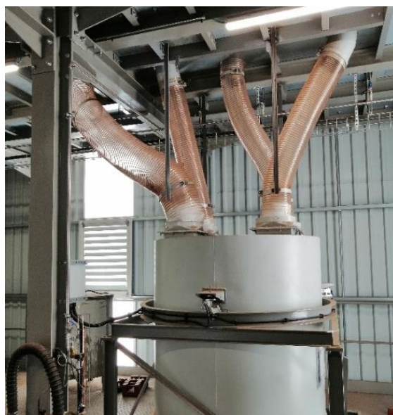
Figura 21 - Alteração da Tubagem entre Silos e Balança
