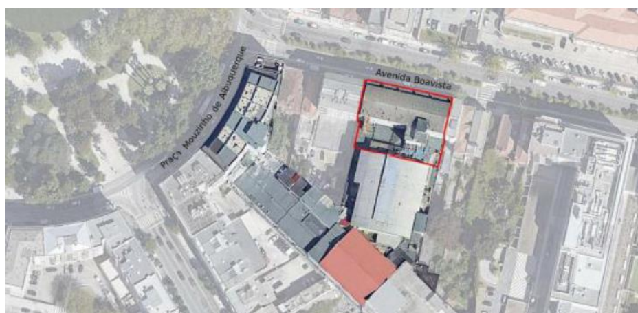
Figura 3.2 - Localização do edifício a intervir (OMATAPALO - Engenharia e Construção, 2022).
