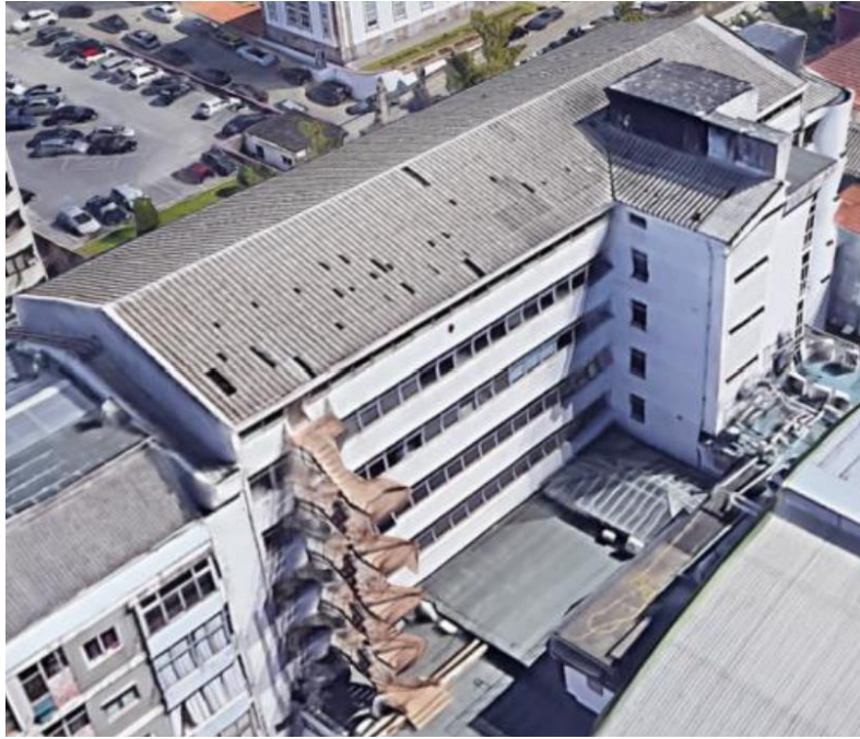
Figura 3.4 - Fachada Sul (OMATAPALO - Engenharia e Construção, 2022)
