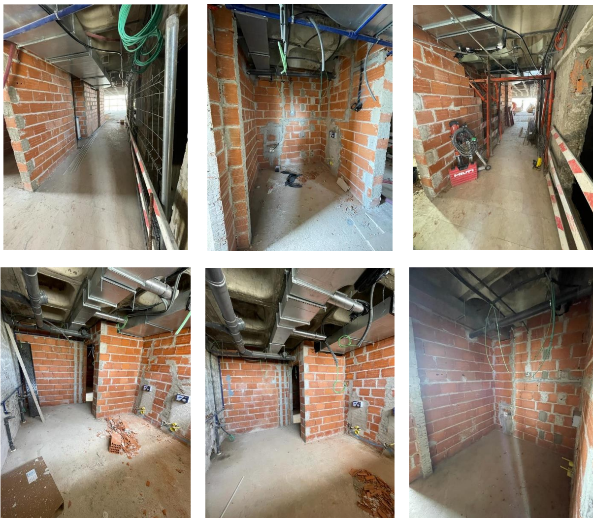
a) Trabalhos de hidráulica e AVAC concluídos no piso 3
