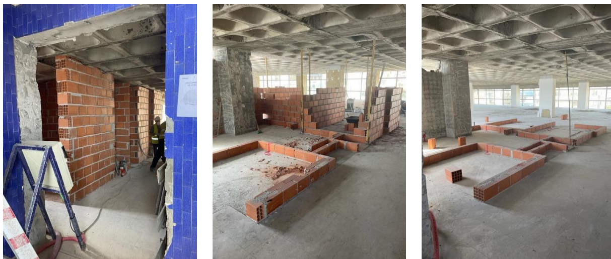
a) Fotografia do piso 5
