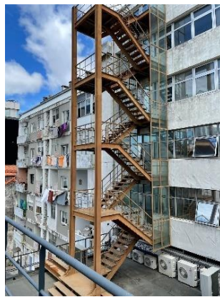
b) Fotografia do estado atual das escadas
