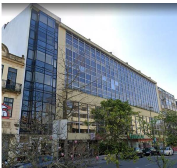
a) Fachada existente
