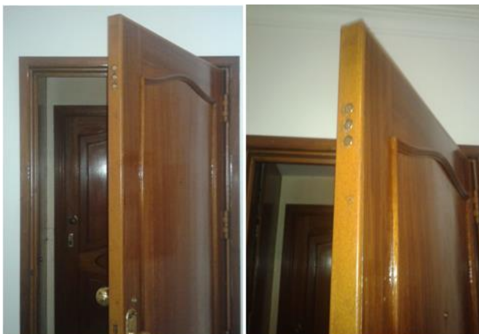
Figura 5.11 – Fechadura da porta de entrada da habitação.
