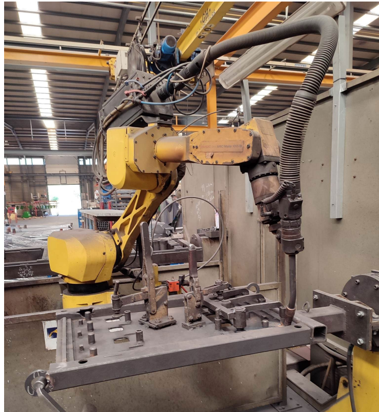
Figura 49 - Robot de soldadura a trabalhar lateralmente
