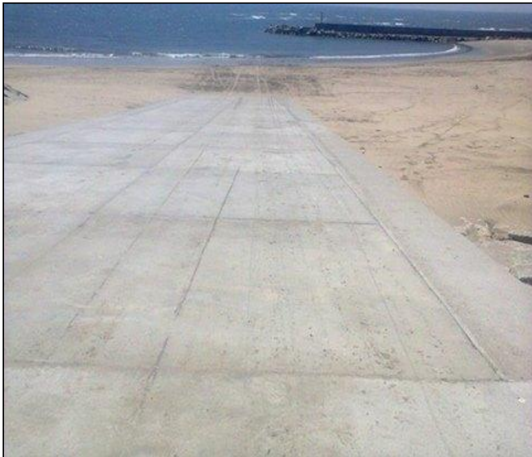
Figura 7 – Rampa de acesso já finalizada
