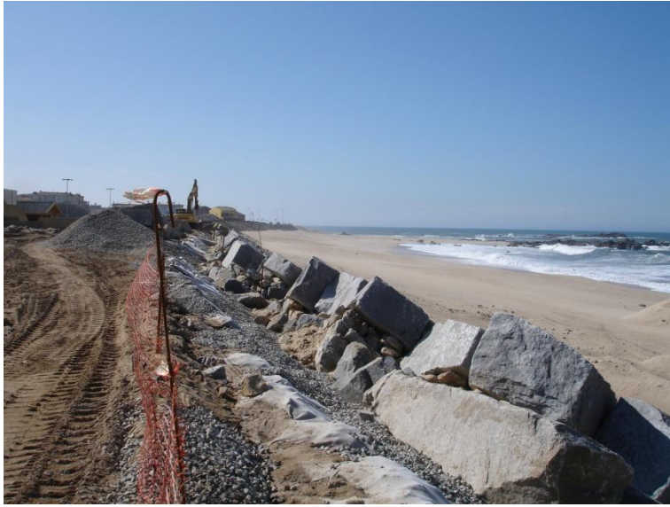
Figura 16 – Pormenor do enrocamento
