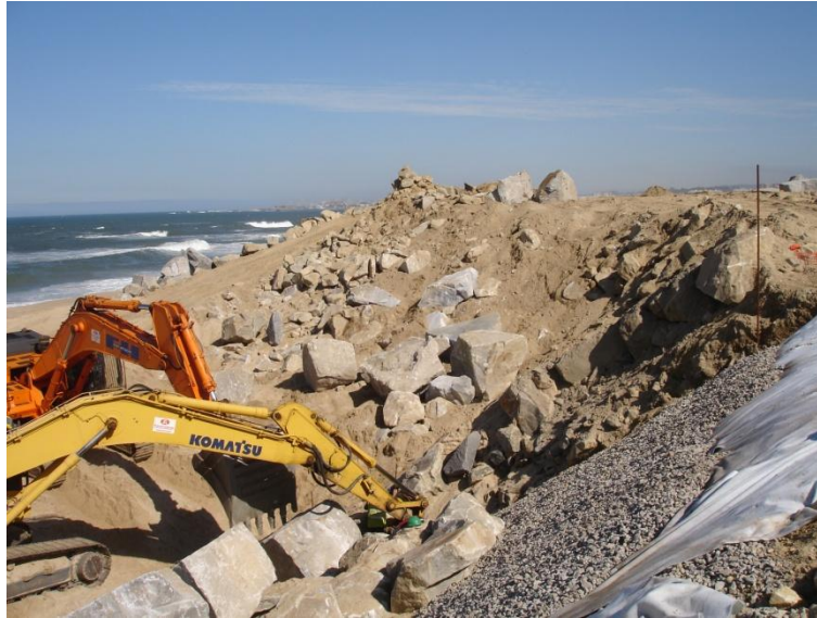
Figura 14 - Fase de escavação
