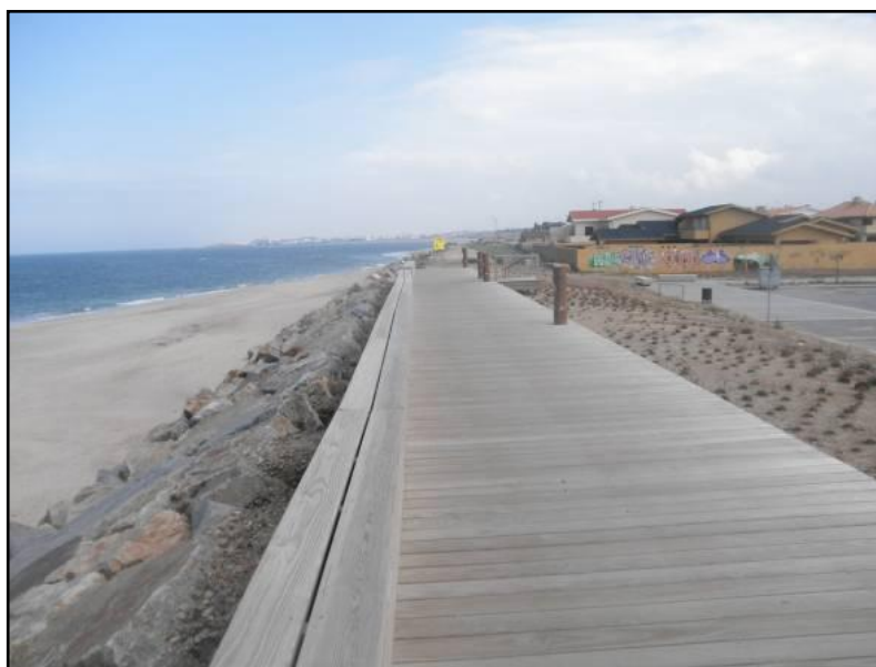
Figura 11 – Passadiço instalada sobre estrutura aderente
