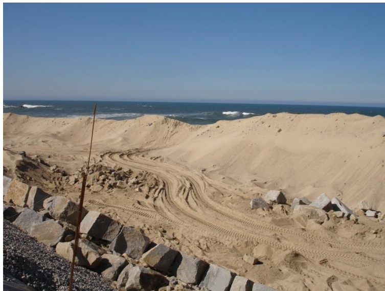
Figura 15 – Construção de dunas com a areia retirada para proteger a zona de trabalho e instalação das primeiras pedras do enrocamento
