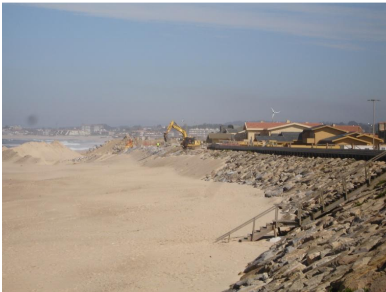
Figura 17 - Foto de uma parte da estrutura aderente já terminada
