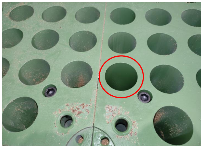
Figura 37 - Comparação entre a cavidade com a limpeza pela escova vs. limpeza com ar comprimido
