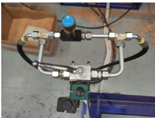
Figura 45 - Mecanismo de redução de caudal aberto
