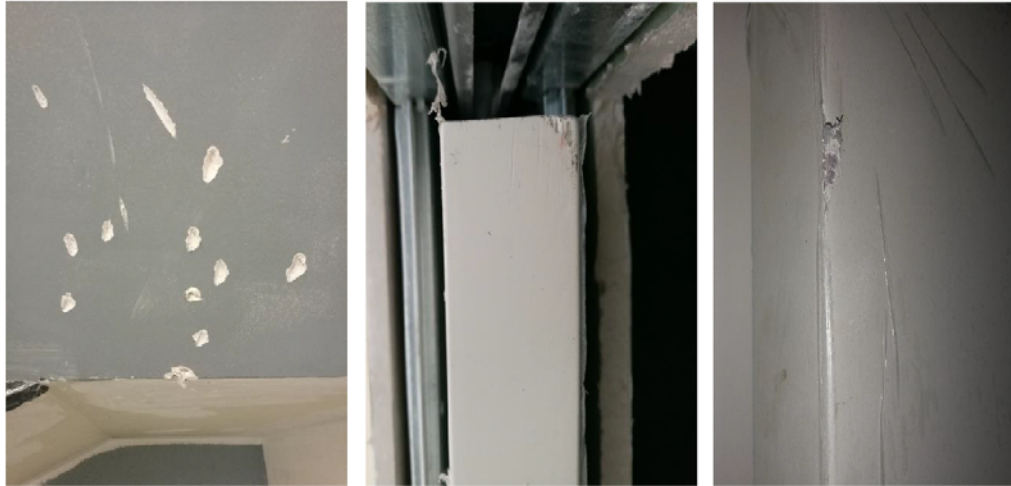
Fig. 12 a 14 – Teto da caixa de escada e estragos nas portas de correr;
