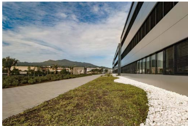
Figura 2.19 - Edifício Sede LIDL (Linhó).
