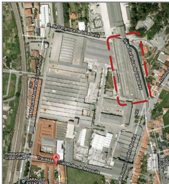
Figura 2.1 - Localização do edifício em estudo [17].
