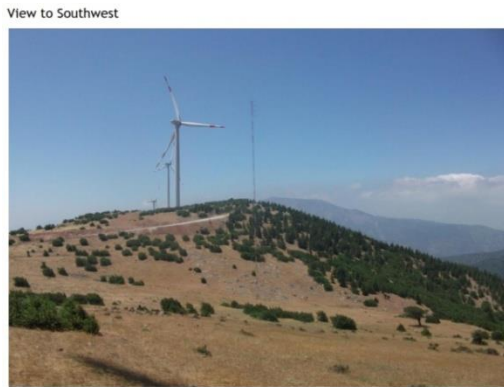
Figura 63 – Vista Sudoeste do local
