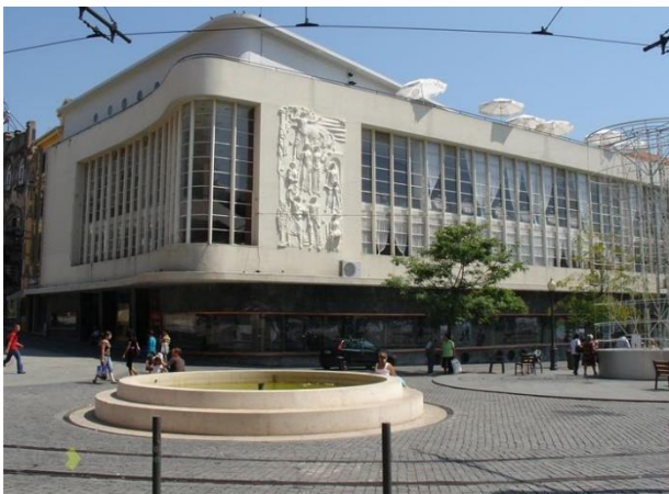
Cinema Batalha, 2006 (Fonte: Sistema de Informação para o Património Arquitectónico)
