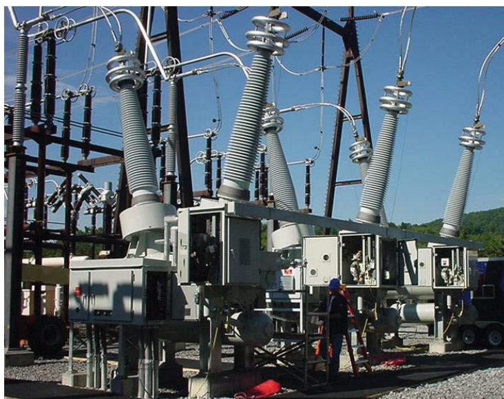
Figura 1- Configuração externa tipo Dead Tank (Megger).
