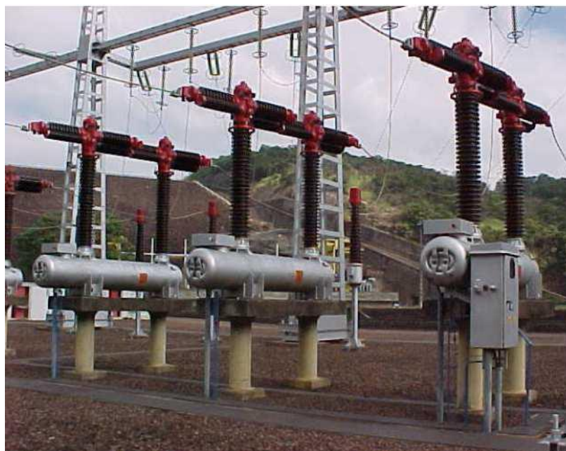
Figura 5- Disjuntor a ar comprimido.
