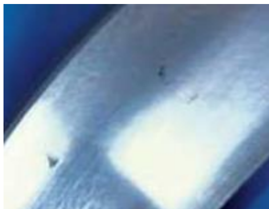
Figura 17: Aspecto das fissuras/picagem [25]
