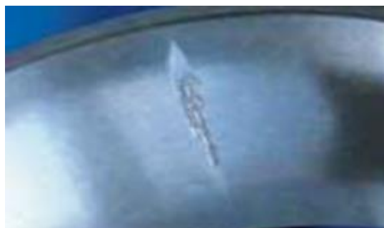
Figura 30: Fissuras no centro da pista de rolamento [25]
