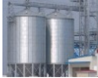
Figura 3.7 – Silo de armazenamento dos cereais (qrbiz.com 10-10-2011)
