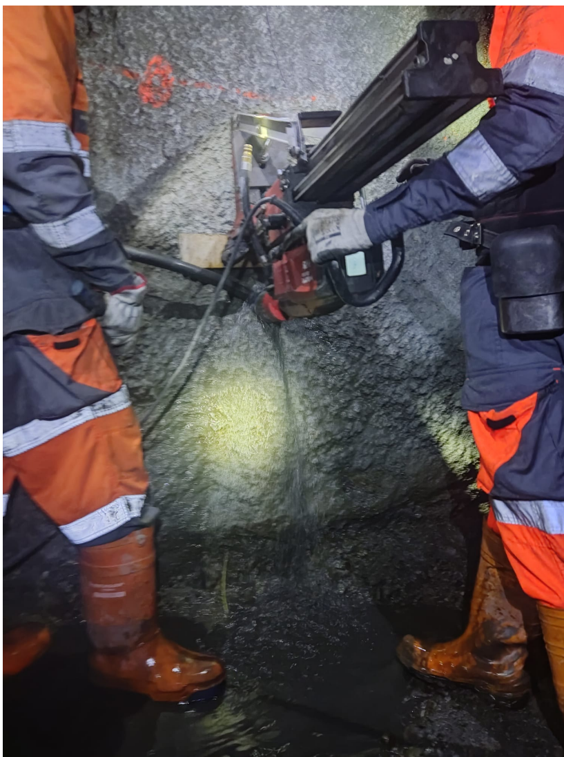
Figura 3.19: Acoplamento da caroteadora ao hasteal da galeria.
