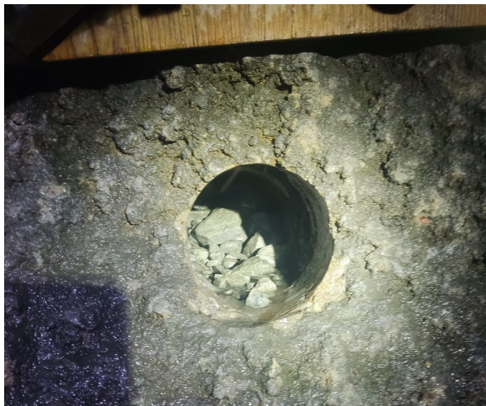
Figura 3.21: Caroteamento abortado em sulfureto maciço - Fragmentação excessiva e impossibilidade de extração de carote.
