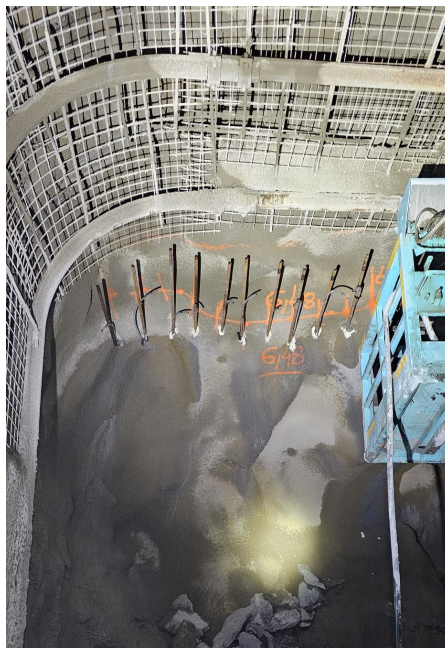
Figura 2.21: Cambotas metálicas, enfilagens e rede malha-sol.
