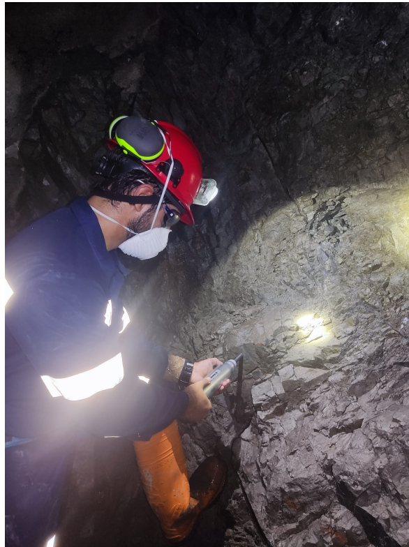
Figura 3.22: Ensaio in situ da resistência à compressão com recurso ao martelo de Schmidt .
