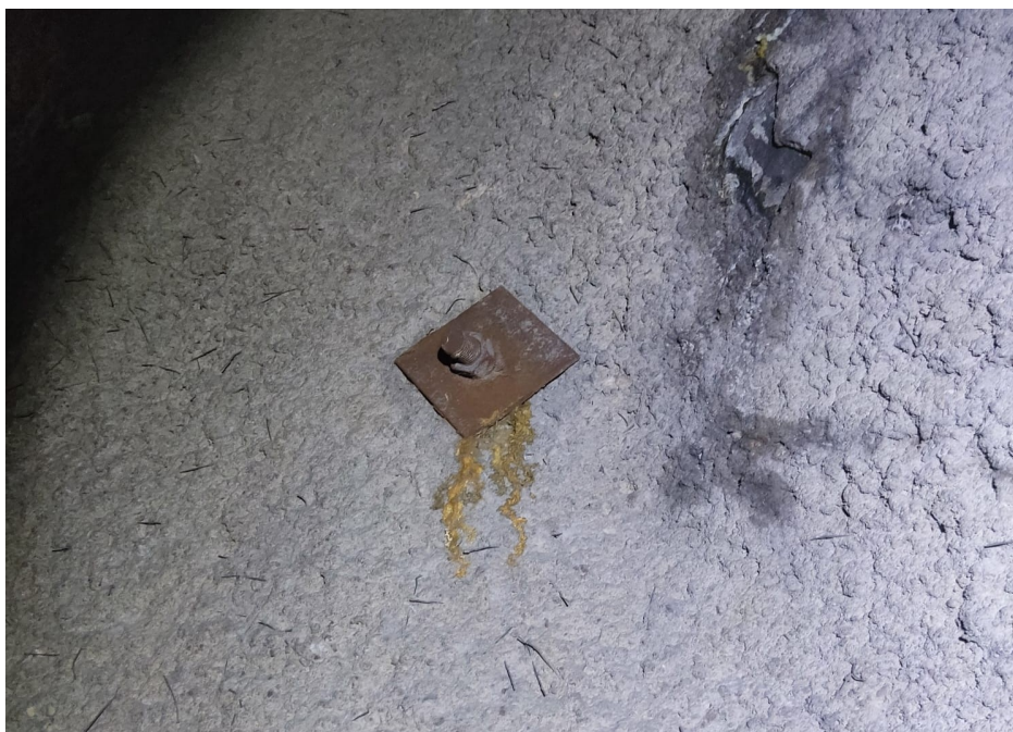
Figura 2.18: Parafuso Heliço selado com resinas de cura rápida.
