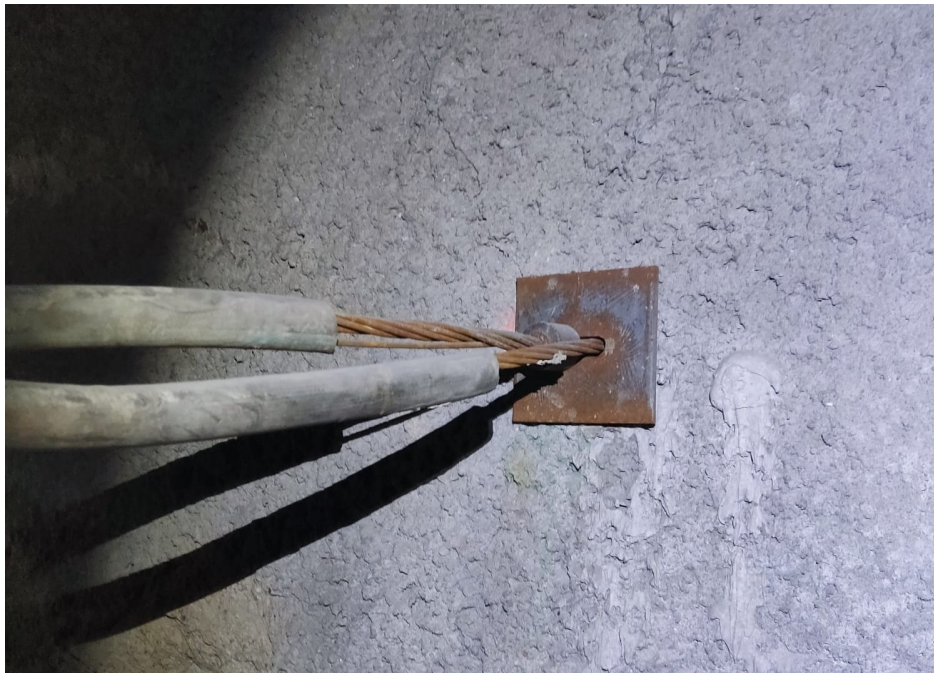
Figura 2.19: Cabos de aço duplos selados com calda de cimento.
