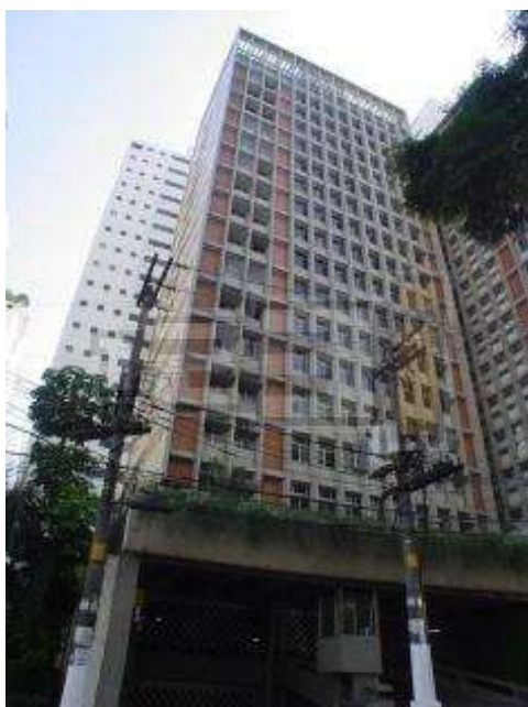
Figura 5.1 – Condomínio Edifício Lago Azul.
