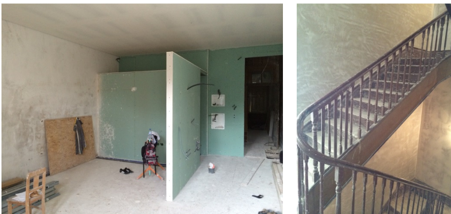
Figura 43 – Paredes interiores prontas a receber os revestimentos finais e parede da caixa de escadas já rebocada, julho 2014.
