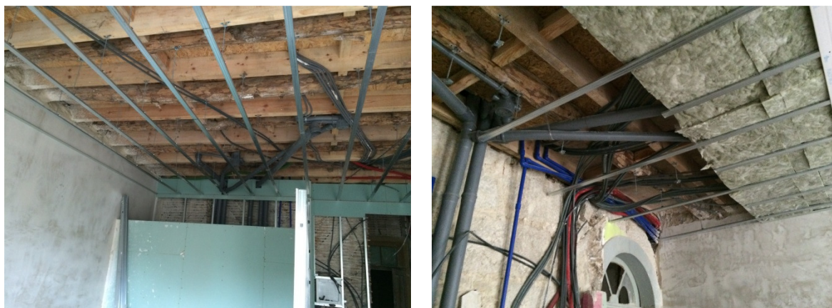
Figura 44 – Instalação da estrutura metálica de suporte, infraestruturas e placas de lã de rocha.
