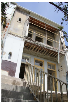
Figura 46 – Demolição dos avançados da parede exterior de tardoz (maio 2014).
