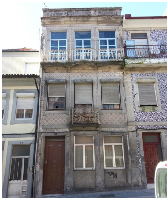
Figura 20 – Alçado principal do imóvel antes da intervenção de reabilitação, Fev. 2014.
