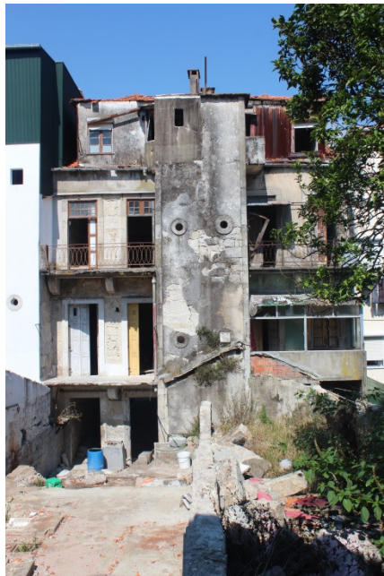
Figura 51 – Alçado posterior do edifício, abril 2014.
