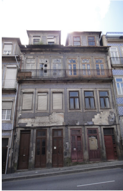
Figura 50 – Alçado principal do edifício, abril 2014.
