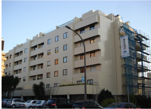
Figura 3 - Fachada exterior de imóvel habitacional – Rua da Quinta, Foz do Douro, Porto, 2012.
