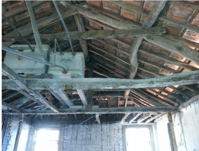
Figura 22 – Aspeto geral da estrutura (asna simples com nível) em madeira da cobertura antes da intervenção de reabilitação, Fev. 2014.
