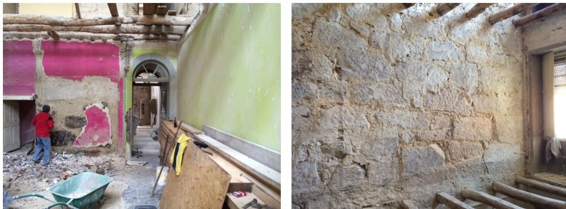
Figura 39 – Remoção dos revestimentos existentes nas paredes, abril 2014.
