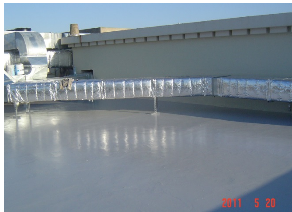
Figura 2 - Cobertura do Instituto Superior Técnico, Lisboa – 2011.
