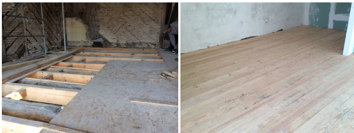
Figura 36 – Colocação dos painéis de aglomerado de madeira (maio 2014) e do pavimento em madeira maciça macheada (julho 2014).
