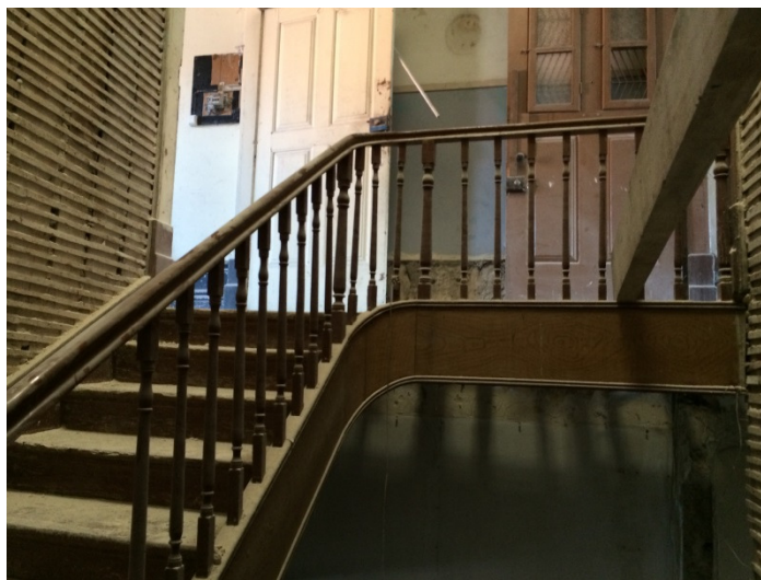
Figura 23 - Aspeto geral da estrutura em madeira da caixa de escadas antes da intervenção de reabilitação, Fev. 2014.
