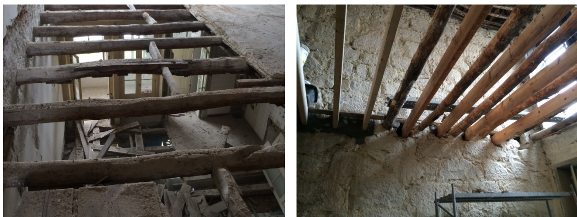
Figura 35 – Demolição do pavimento e reforço das vigas de madeira (abril 2014)
