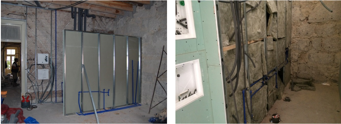
Figura 42 – Instalação das infraestruturas e colocação de painéis de lã de rocha.
