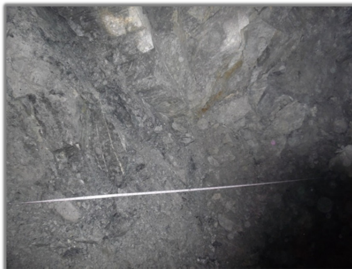
Figura 2. Exemplificação de uma frente de escavação rochosa com fita graduada na soleira para levantamento com recurso à técnica das "scanlines" (foto: Cláudio Santa; Túnel do Marão, Maio de 2015).
