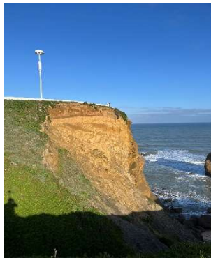
Arriba lado esquerdo (L10) com evidências de deslizamentos
