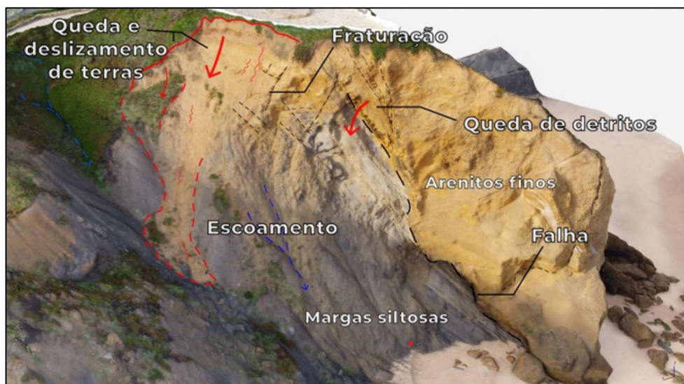
Figura 40 - Processos erosivos no Miradouro da praia da Formosa (14/04/2021), com a identificação da queda de terras e deslizamento de material registado a 10 de abril de 2021 (extraído de Ramos 2021).
