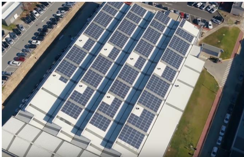
Figura 2 - Instalações da Efacec Electric Mobility, S.A..
