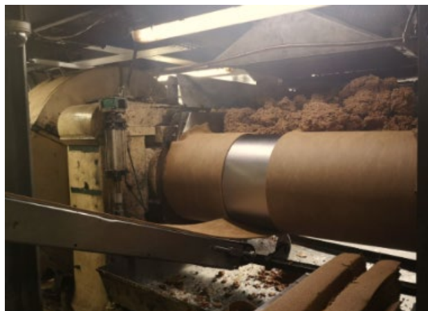
Figura 32. Misturador aberto de homogeneização.
