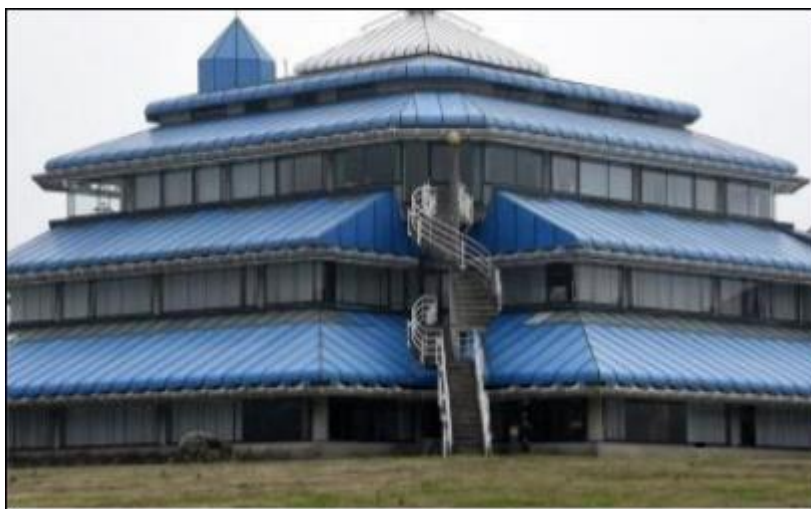
figura 4 - Sede da TMG S.A., Fonte: Portal TMG
