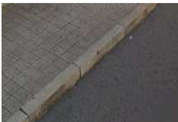
a) Passeio em betonilha esquartelada (Valongo, 2016)
