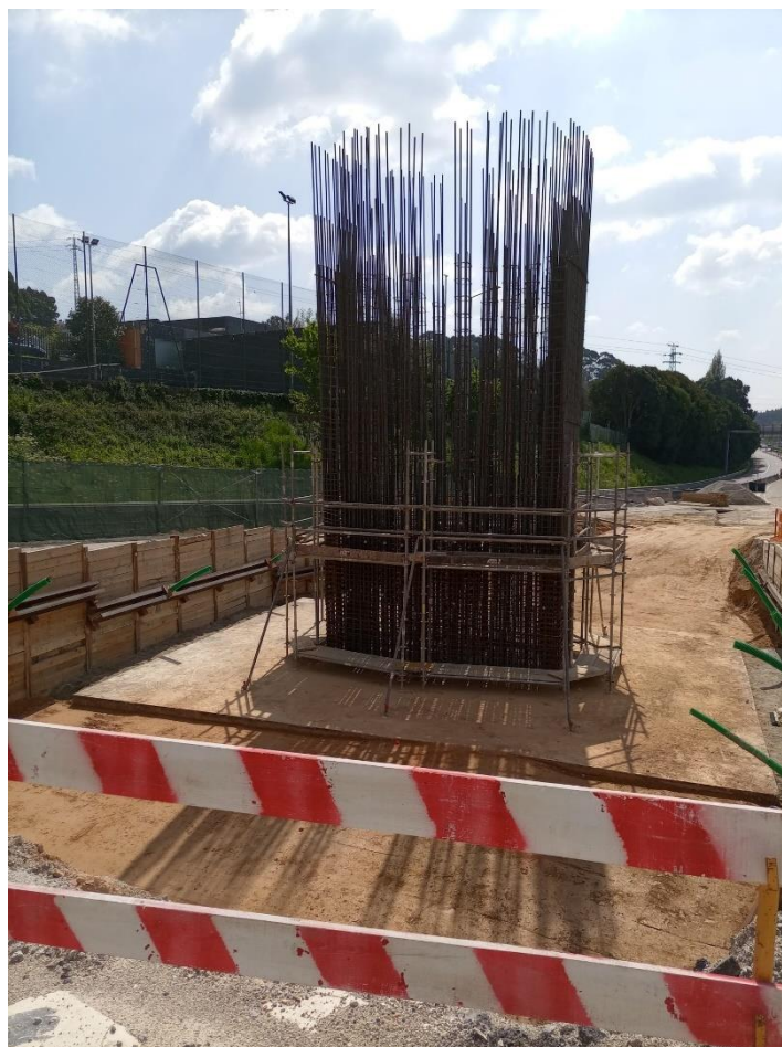
Figura 4-36 - Armadura Fase 1 e 2 Pilar P3
