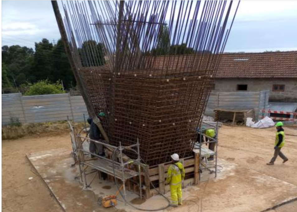
Figura 4-53 - Betonagem maciço de arranque Pilar P6
