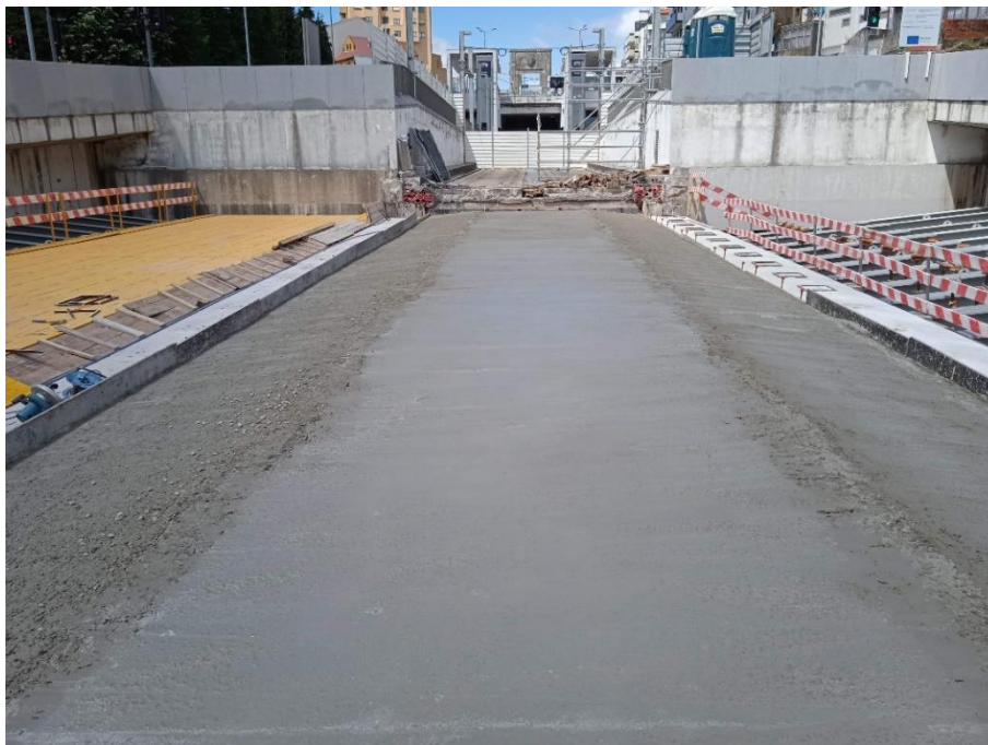
Figura 4-59 - Aplicação de camada de regularização do tabuleiro do VRT (Fotografia de Eng. Artur Patrão)
