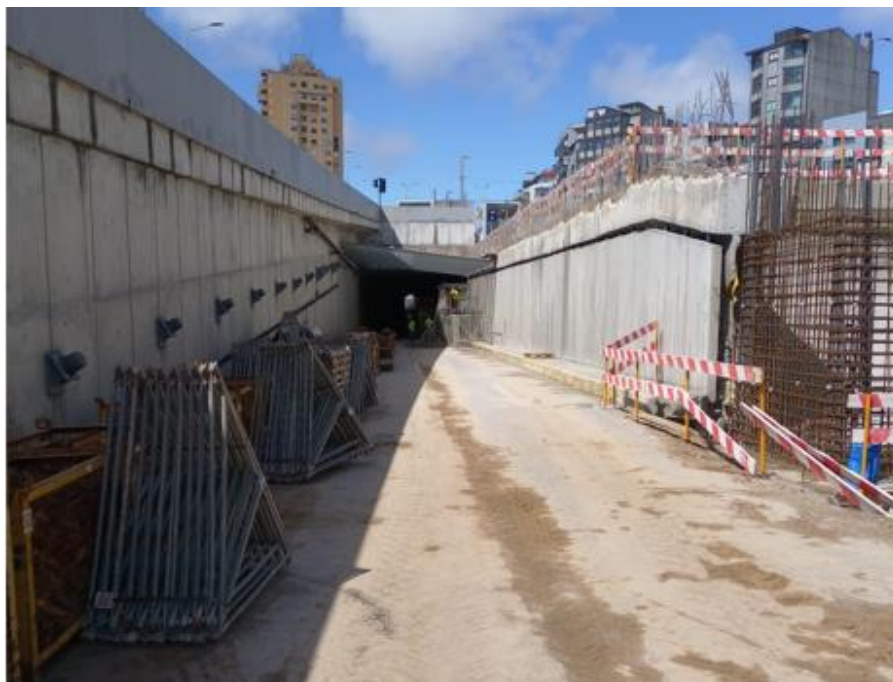
Figura 4-45- Montagem do cimbra tabuleiro VRT
