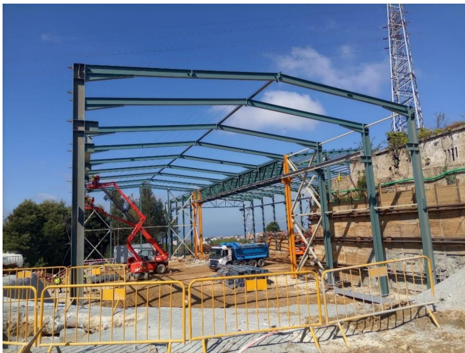
Figura 4-55 - Montagem Parque de Deslize
