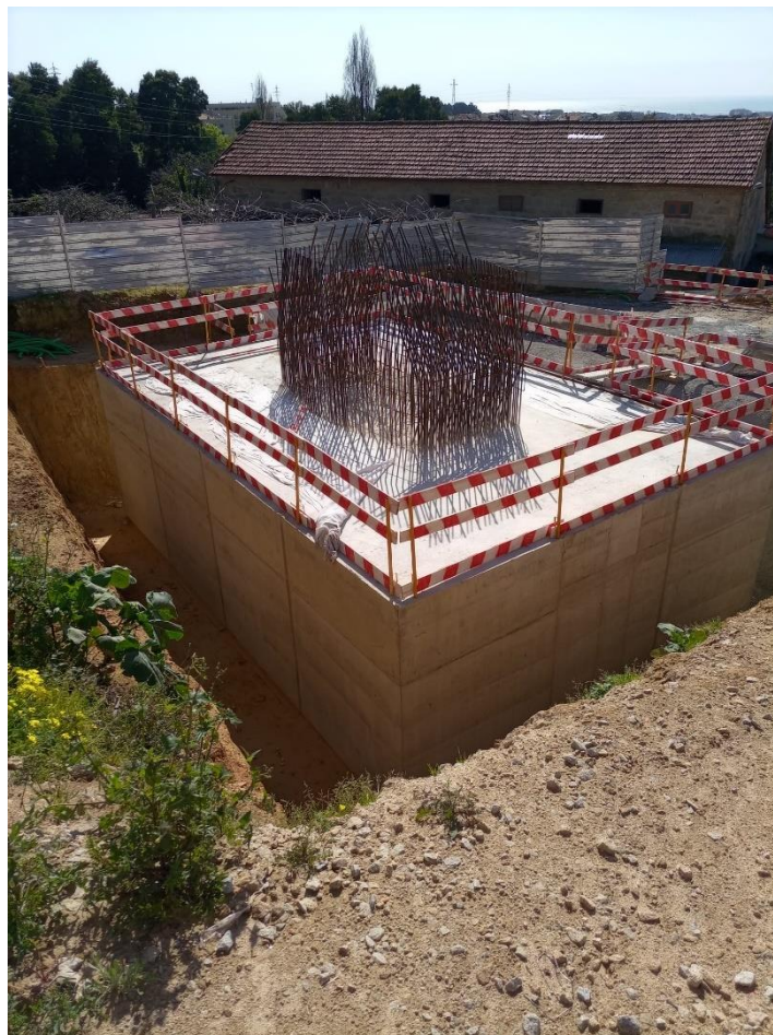
Figura 4-39 - Maciço de fundação Pilar P6
