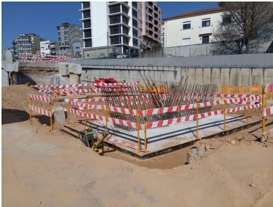
Figura 4-31 - Aterro Pilar maciço de fundação P1N
