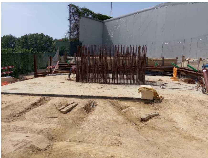
Figura 4-67 - Restabelecimento da armadura do Fuste Pilar P4
