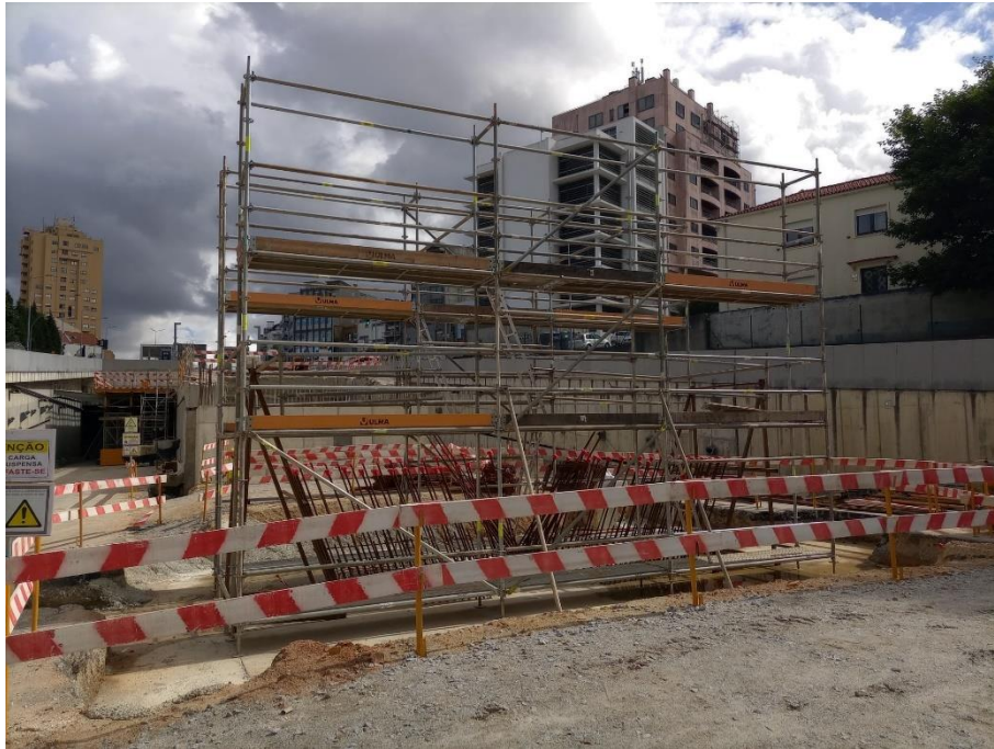
Figura 4-61 - Pilar P1N Montagem de andaime
