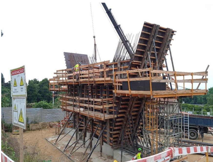
Figura 4-68 - Cofragem 3 fase capitel P6 (Fotografia de Eng. Artur Patrão)
