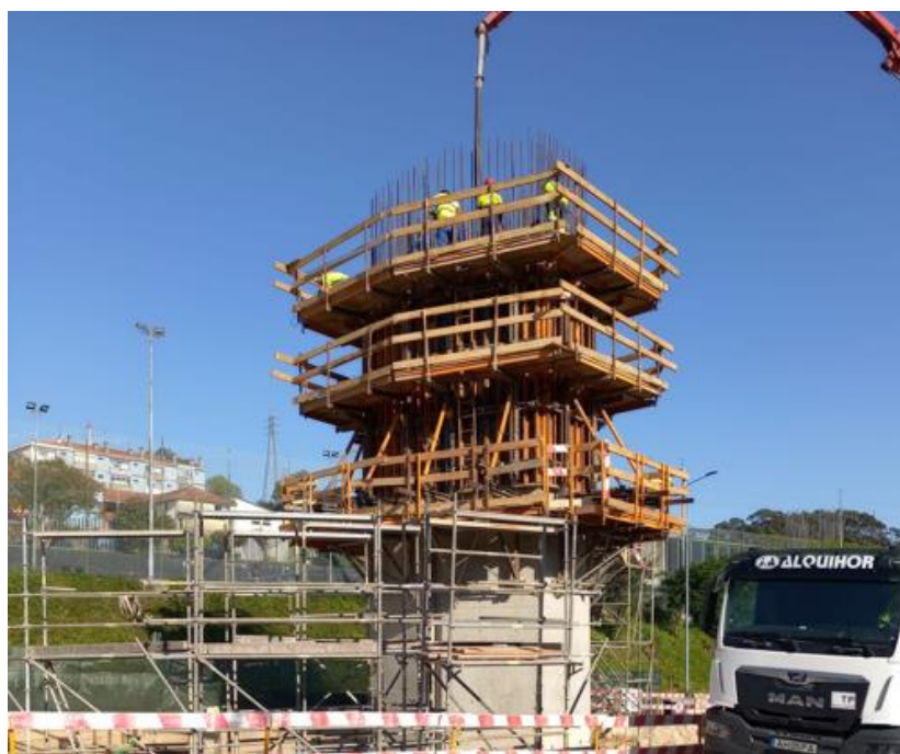
Figura 4-51 - Betonagem fuste fase 3 Pilar P3
