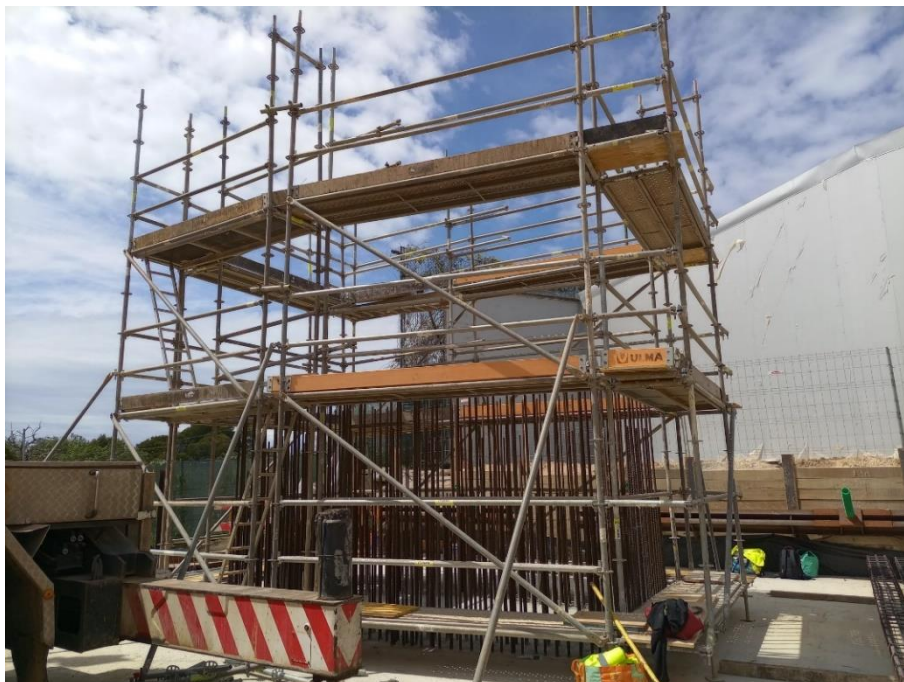
Figura 4-52 - Execução da armadura do fuste fase 1 e 2 Pilar P4
