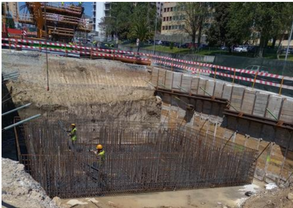
Figura 4-50 - Armadura maciço de fundação P2
