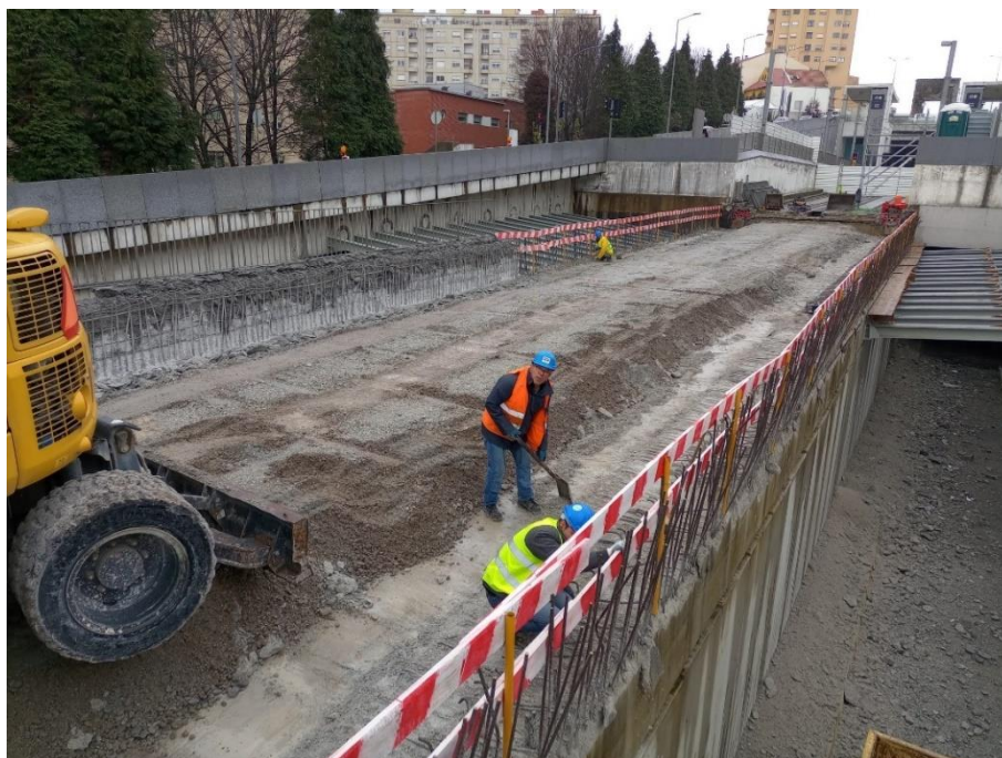
Figura 4-29 - Trabalhos de Demolição VRT
