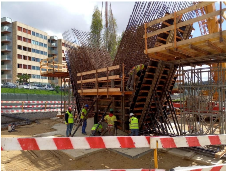
Figura 4-34 - Cofragem Fase1 Pilar PT1
