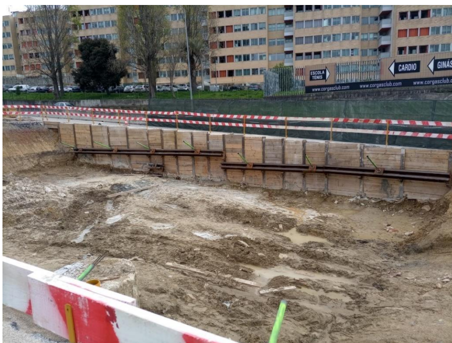
Figura 4-35- Execução de Muro de Berlim Pilar P2
