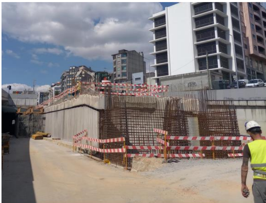
Figura 4-46 - Armadura dos muros laterais do Encontro 1
