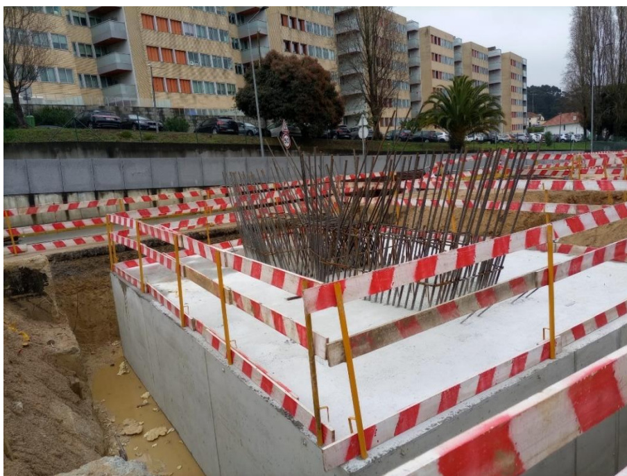
Figura 4-32 - Maciço de Fundação Pilar P2N
