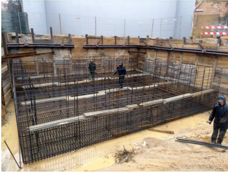
Figura 4-37 - Armadura do maciço de fundação Pilar P4
