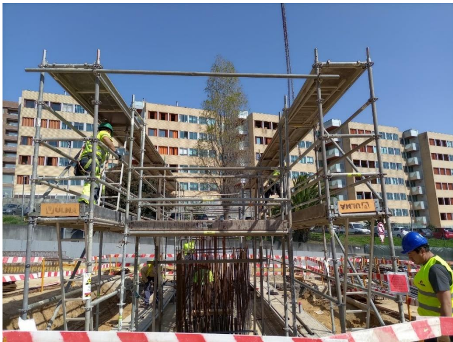
Figura 4-33 - Armadura Fase 1 Pilar P3N
