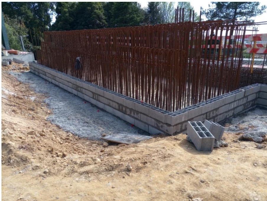
Figura 4-54 - Execução de muro de alvenaria. Encontro E7
