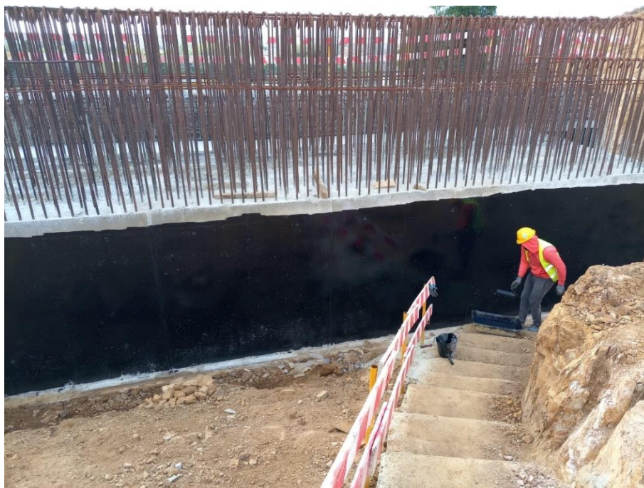
Figura 4-40 - Impermeabilização Encontro E7
