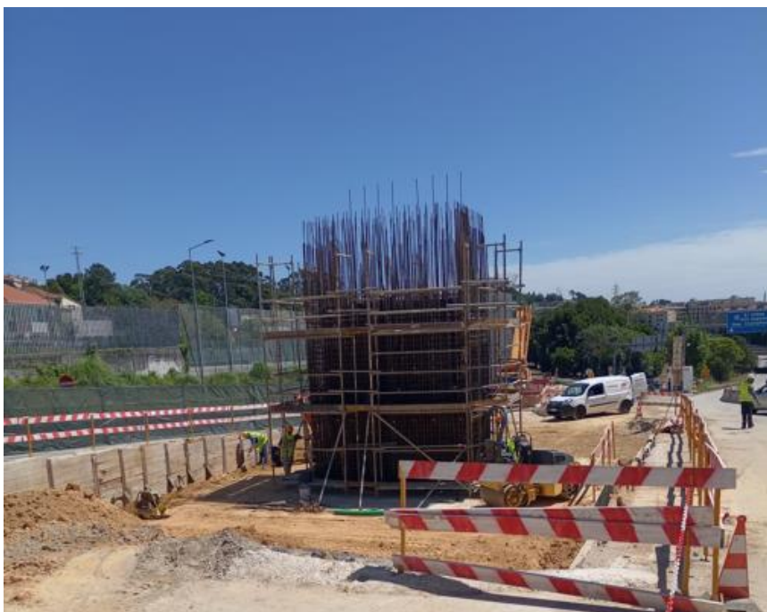
Figura 4-65 - Armadura do fuste fase 1 Pilar P2
