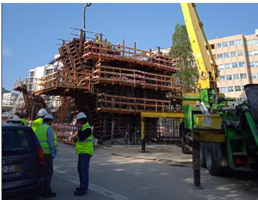
Figura 4-49 - Betonagem Fase 3 capitel PT1 (Fotografia de Eng. Artur Patrão)
