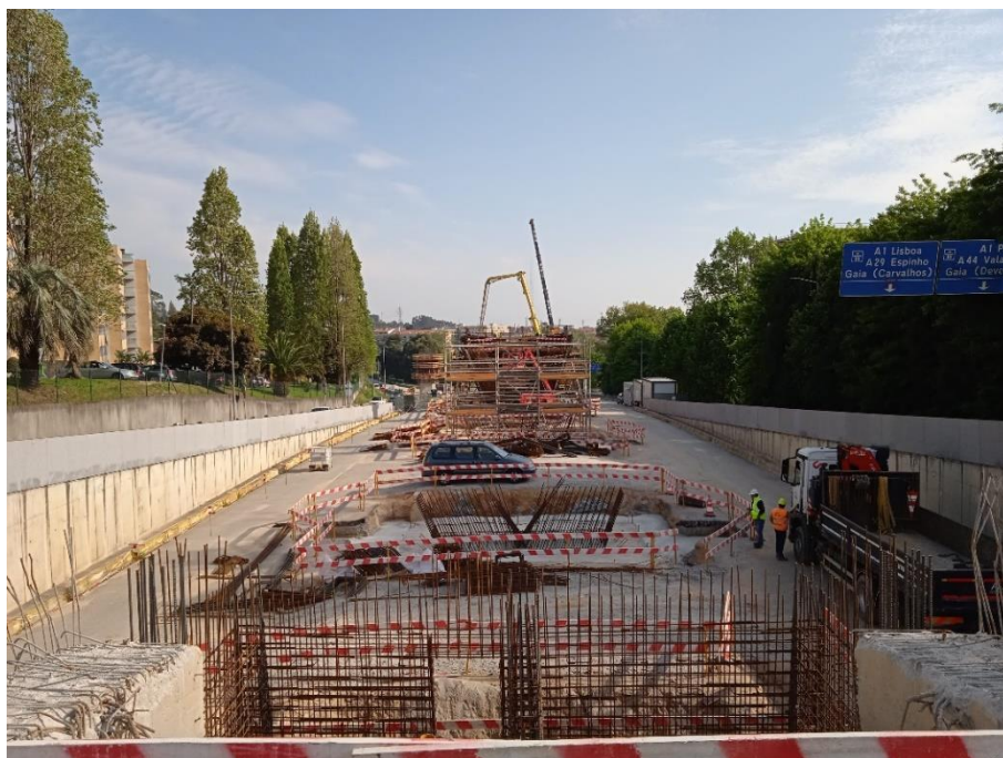
Figura 4-47 - Montagem de Andaime Pilar P2N (Fotografia de Eng. Artur Patrão)
