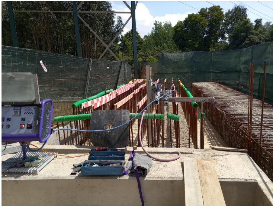
Figura 4-69 - Hidrodemolição no Encontro E7
