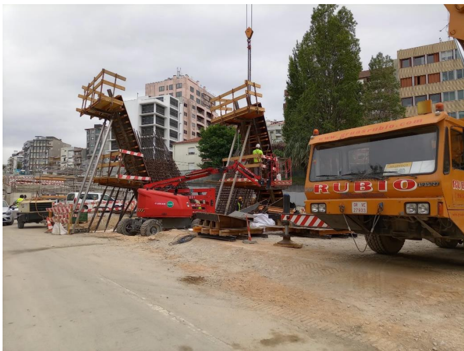
Figura 4-62 - Cofragem Pilar P2N
