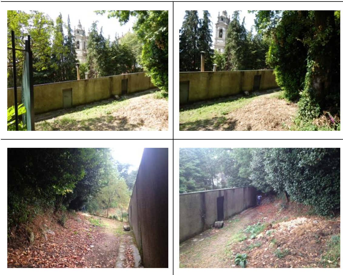
Figura 4.15 - Vista geral da localização escolhida para o silo
