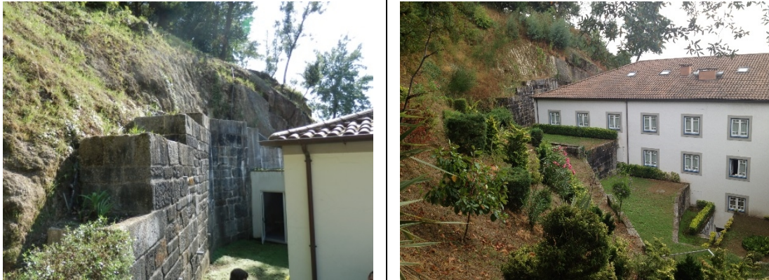
Figura 4.43 - Visualização do local onde a tubagem ficará à vista
