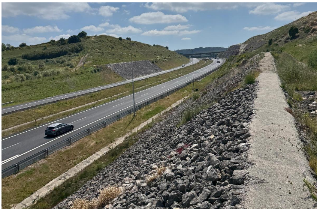
Figura 1 - Talude de escavação na A16, na Concessão Grande Lisboa.
