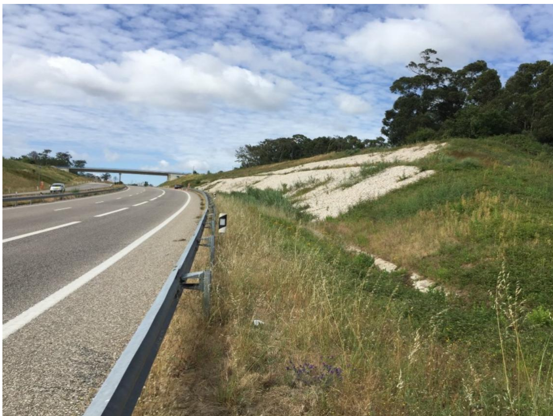
Figura 37 - Talude de escavação CP.AVR.A17.100+540.TE.C.D.SL na A17.
