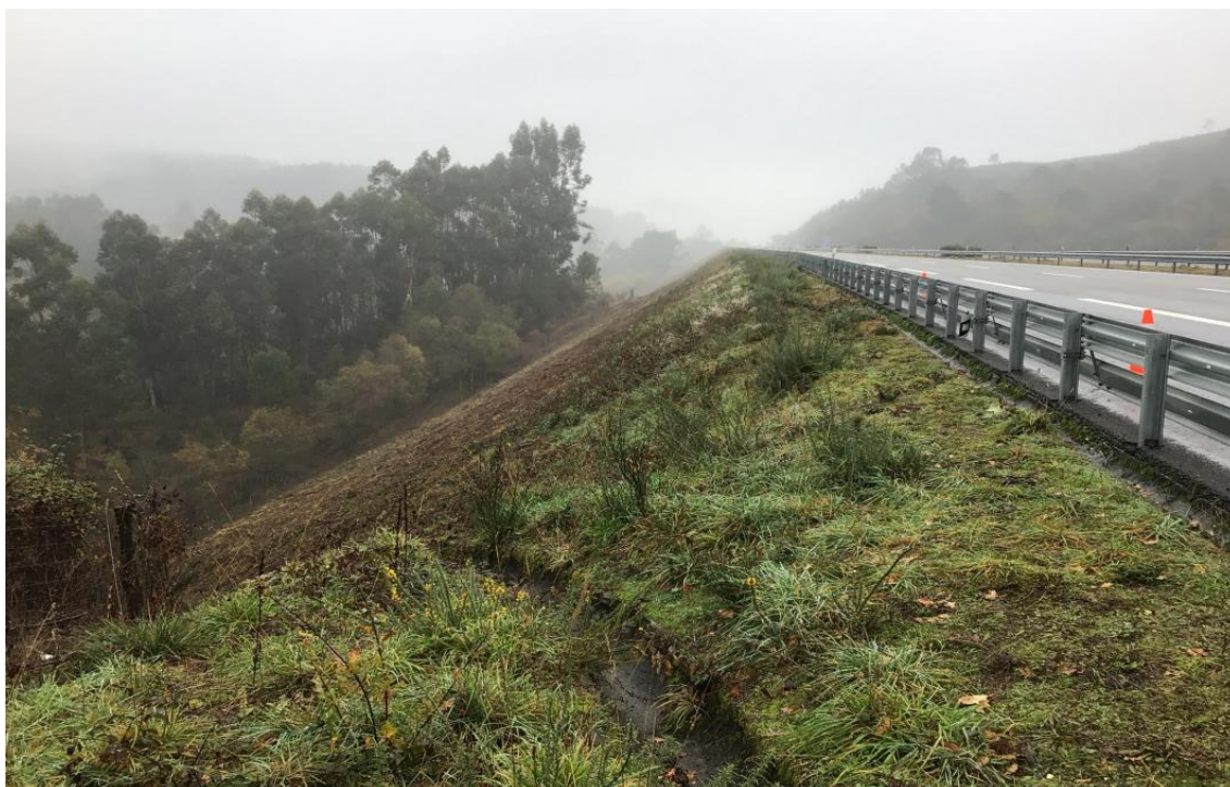
Figura 38 - Talude de aterro AEN.BRG.A7.066+586.TA.D.D.SL na A7.
