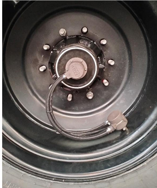
Figura 65 - Instalação das válvulas de ar das rodas e ligação com as uniões rotativas
