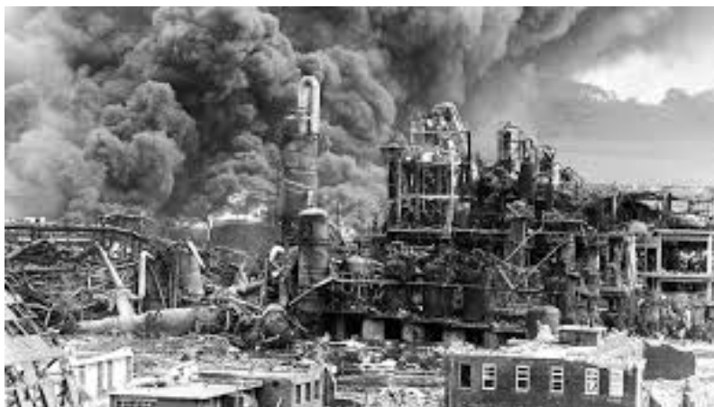
Figura 2.10: Destruição causada pelo acidente, Flixborough 1974.
