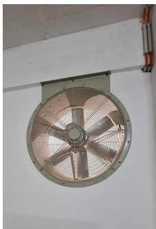
Figura 3.18: Ventiladores de Extração - Pormenor de Instalação
