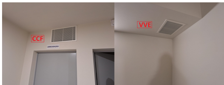
Figura 3.22: Ventiladores de Pressurização - Pormenor de Instalação Interior
