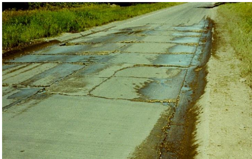
Figura 39 – Exemplo de representação de degradação por erosão ( in pavementinteractive.org )
