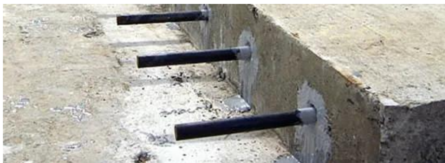
Figura 29 – Exemplo de barras de transferência embebidas na laje ( in alemdainercia.com)
