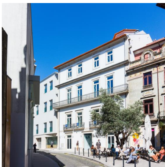
Figura 2.4 - Hotel Carlos Alberto (Omega - Serviços de Engenharia, Lda., s.d.).
