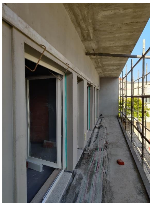
b) Piso 2 edifício Sr.ª Luz
