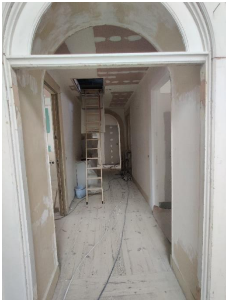
c) Piso 1 edifício principal.
