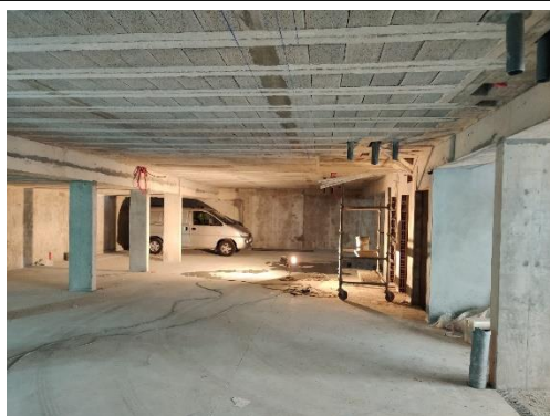
a) Garagem edifício Sr.ª Luz.
