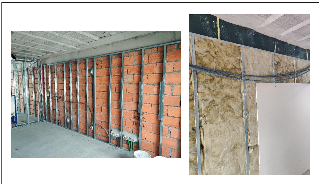
Figura 4.47 – Colocação pladur edifício novo.
