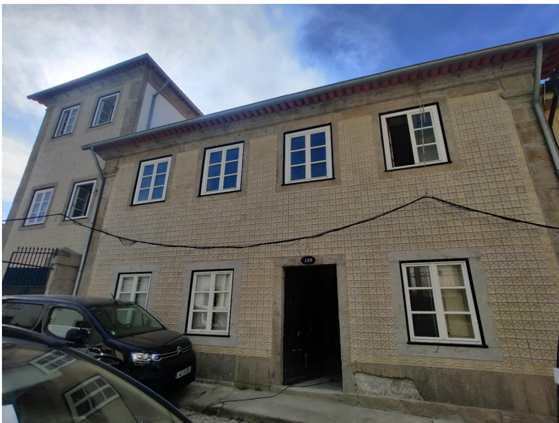
Figura 4.24 – Fachada casa Ferreirinha.
