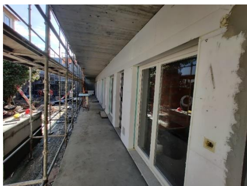
c) Piso 1 edifício Sr.ª Luz.
