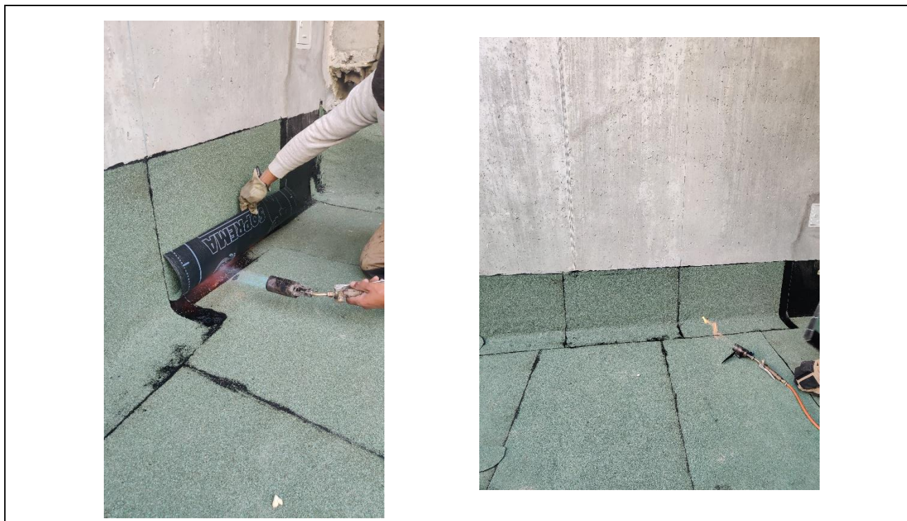
Figura 4.46 – Colocação de telas impermeabilizadoras no logradouro.
