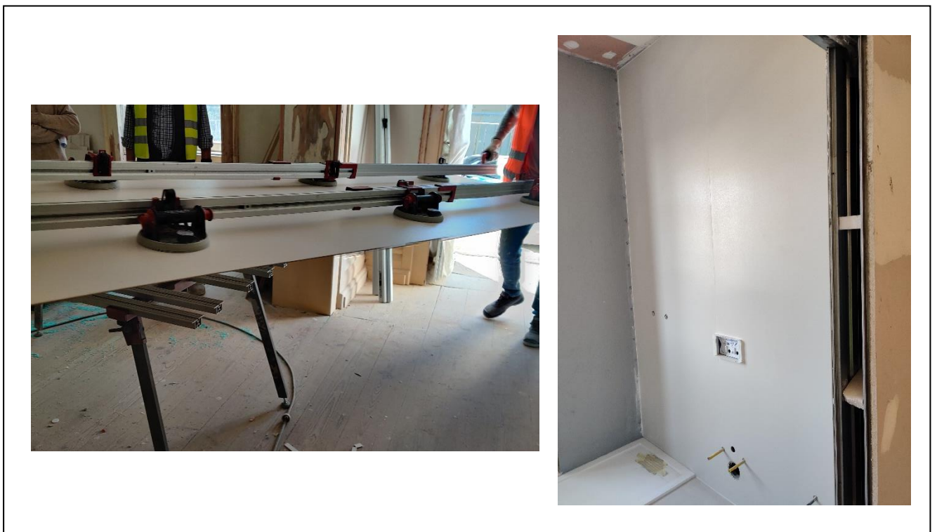
Figura 4.43 – Colocação kerlite nas instalações sanitárias do edifício antigo.
