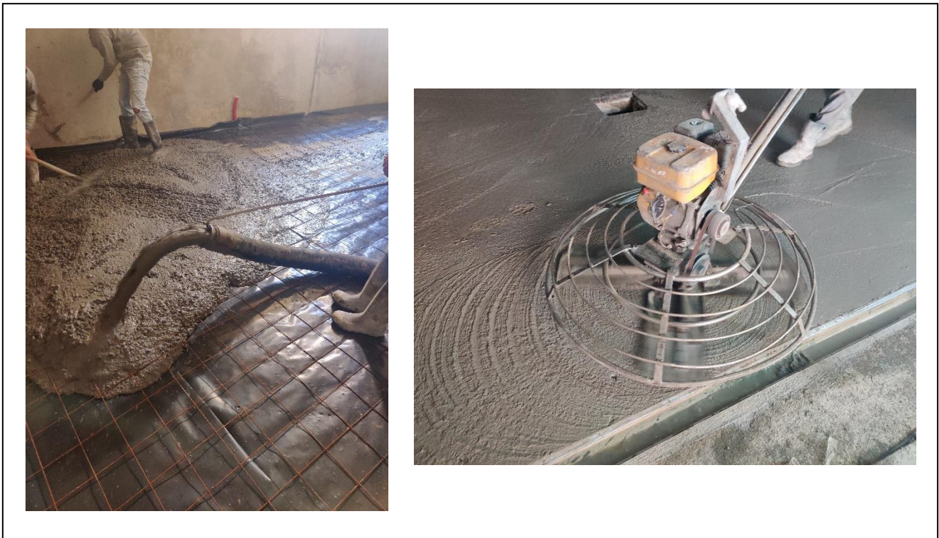
Figura 4.44 – Betonagem pavimento térreo garagem edifício novo.
