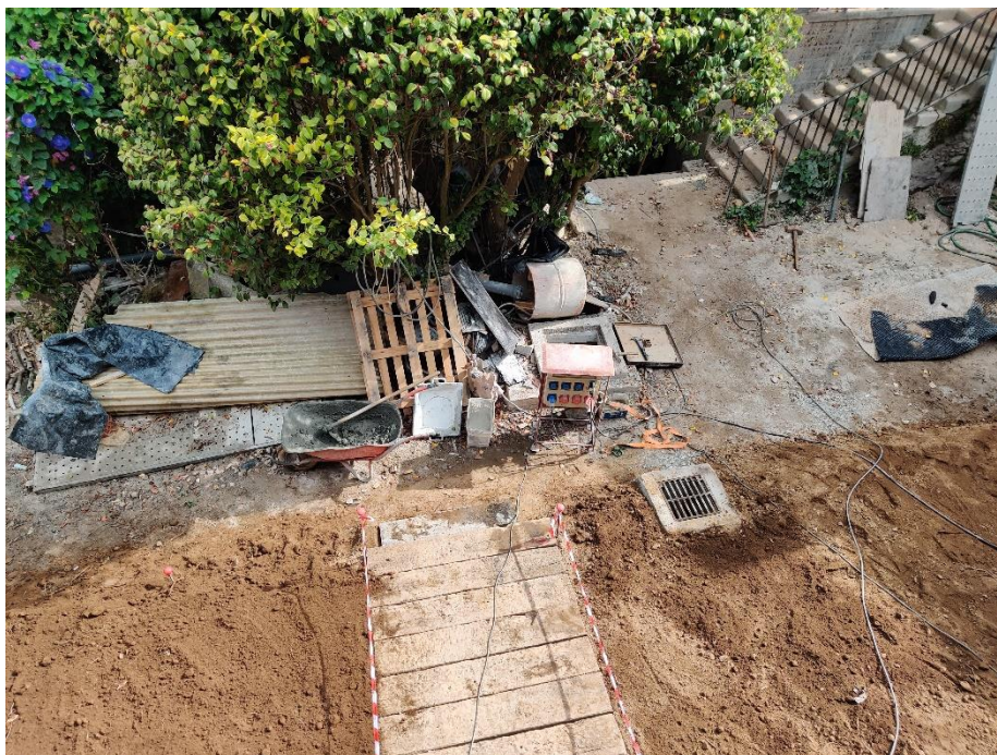
Figura 4.29 – Caminho entre edifícios.
