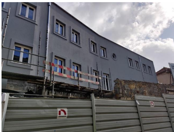
Figura 4.26 – Fachada Edifício Sr.ª Luz.
