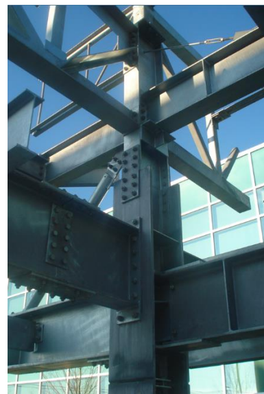
b) Exemplo de Ligação de segmentos de peças por chapa cobre-juntas. 5
