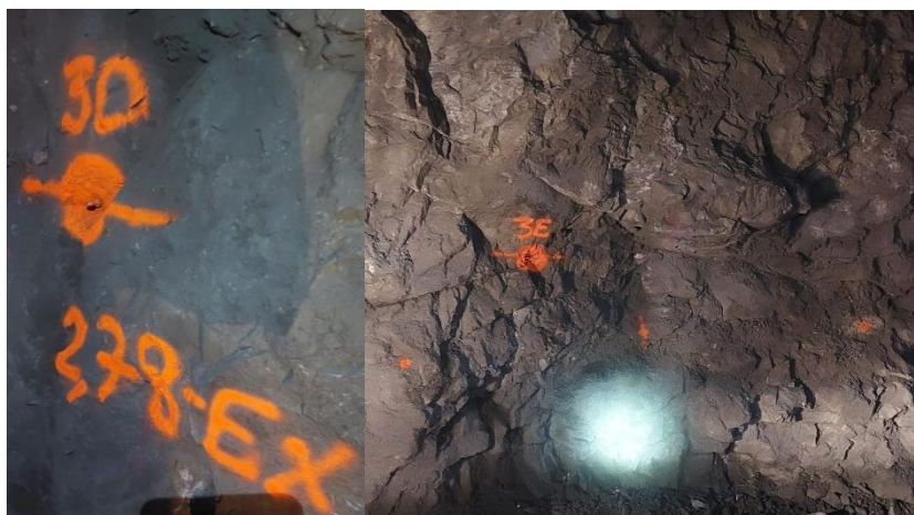
Figura 26 - Suportes topográficos utilizados para realização das rasantes (Fotos: AR, com autorização da ALMINA – Minas do Alentejo).
