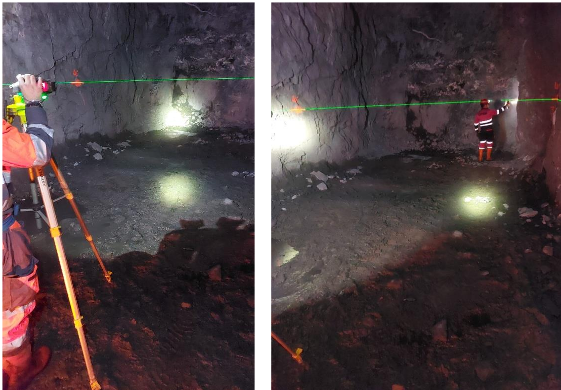
Figura 35 - Marcação do eixo com recurso a laser . À esquerda o posicionamento e ajuste e à direita a marcação com spray (cortesia: ALMINA – Minas do Alentejo).
