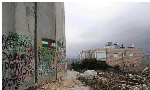
Figura 3.32 – Pinturas indesejadas em betão.
