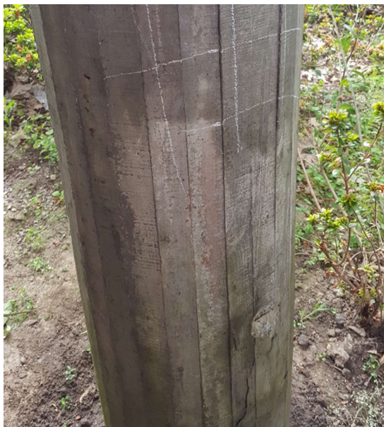
Figura 5.46 – Pilar de escadas de acesso ao Auditório Magno
