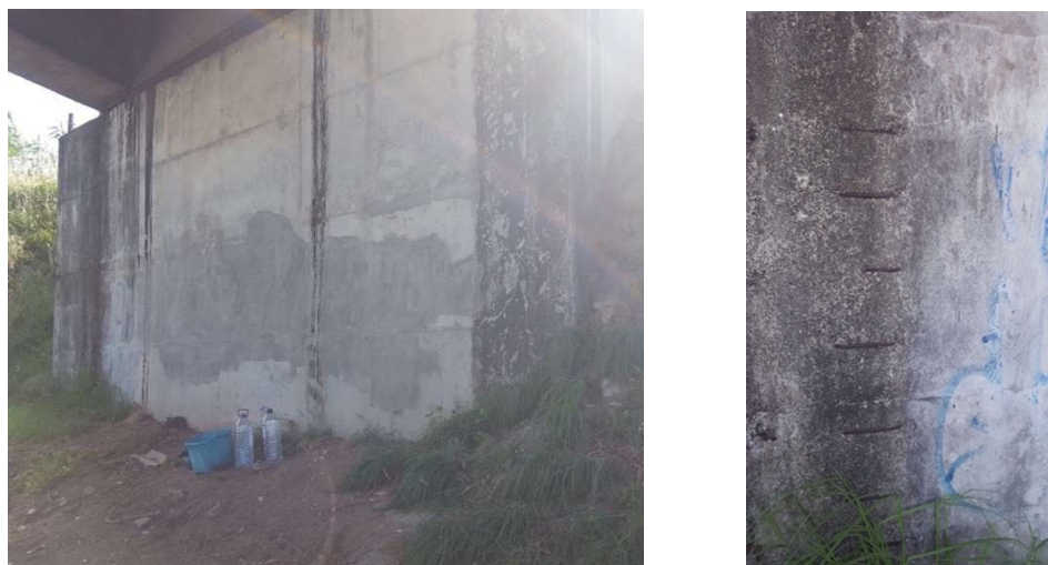
Figura 5.49 –Parede de contenção alvo de estudo
