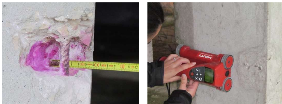
Figura 6.22 – Ensaio de medição da profundidade de carbonatação e medição do recobrimento .
