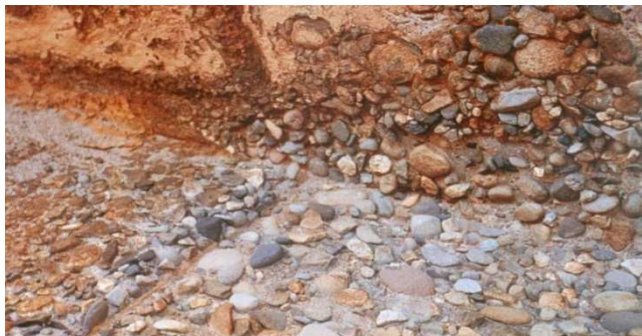
Figura 3.18 – Superfície de betão desagradada devido ao ataque de ácido (Costa, 2012).
