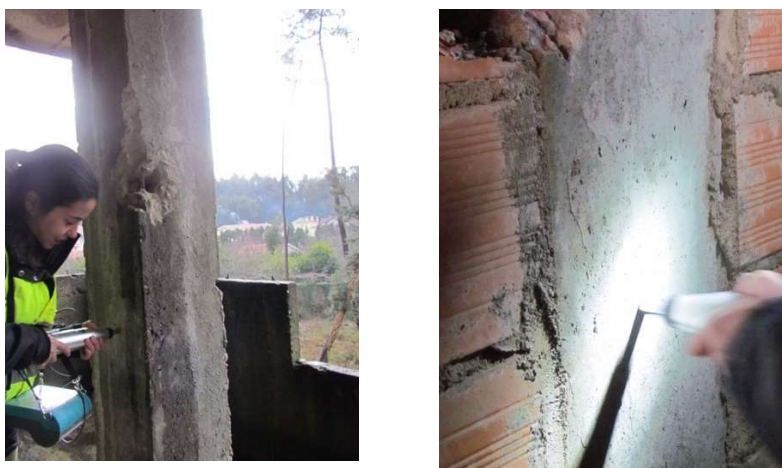
Figura 6.18 – Execução do ensaio de determinação de dureza superficial – Esclerómetro.
