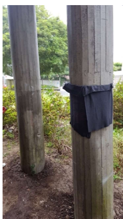
Figura 5.47 – Pilares de escada de acesso ao Auditório Magno
