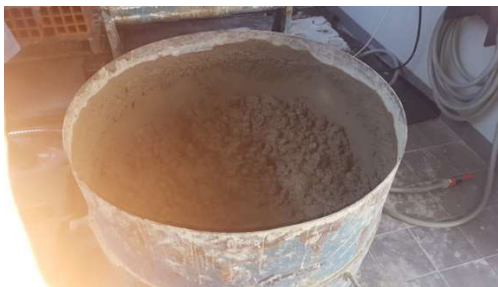
Figura 5.31 - Amassadura de betão.
