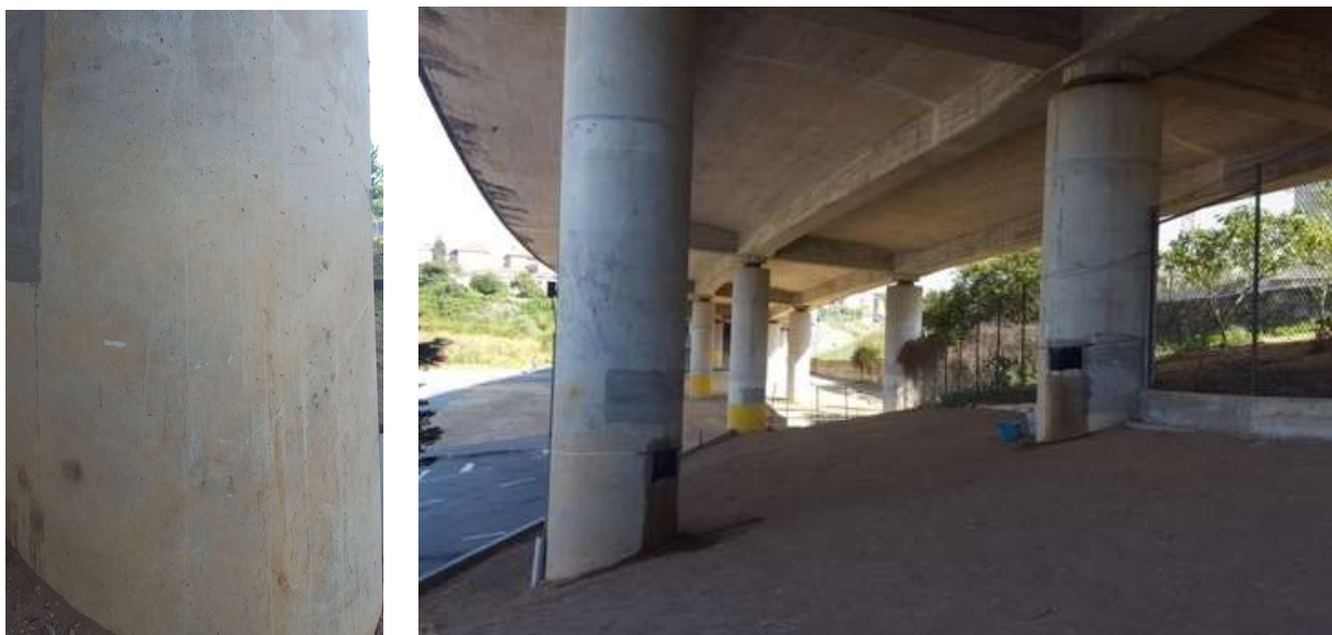
Figura 5.48 – Pormenor de Pilar (Esq.)- Pilares do viaduto da VL8 (Dir.)
