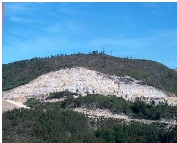
Figura 58 – Obra A7 - Zona de trabalho.
