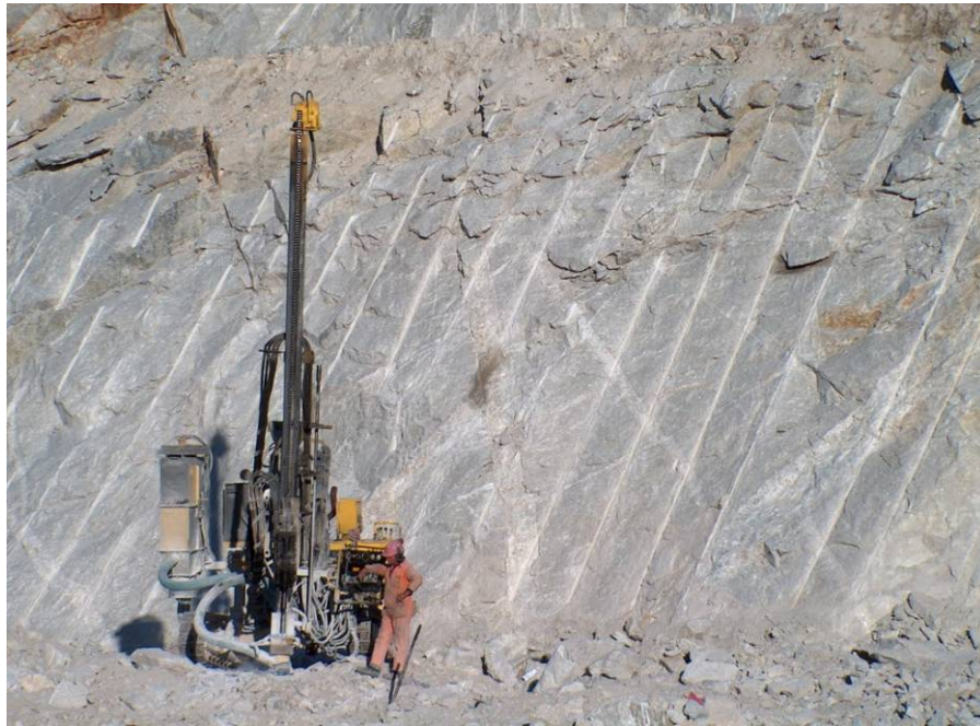
Figura 79 – Parede definida com recurso a pré-corte segundo o plano pré-determinado (A7).
