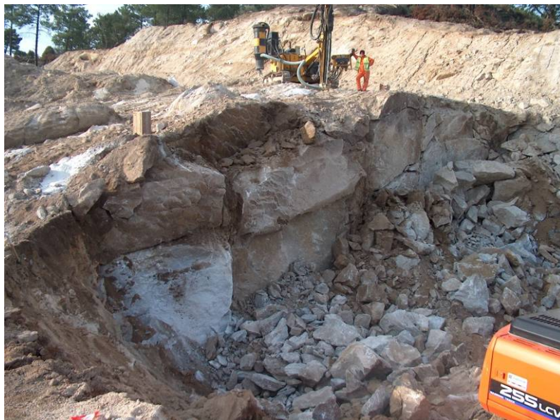
Figura 67 – Grandes blocos em obra rodoviária – Valpaços.
