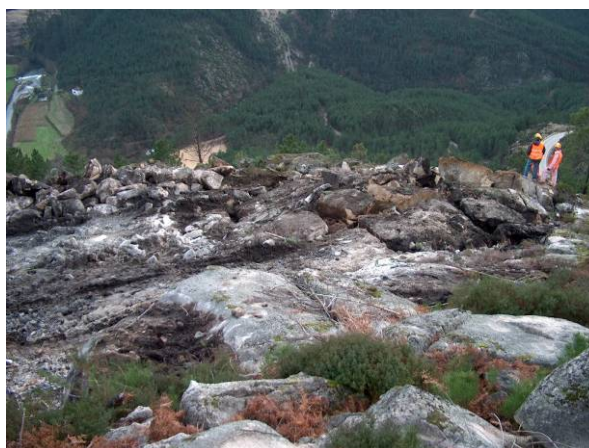
Figura 73 – Maciço granítico na obra A7 antes da desmatagem e decapagem.
