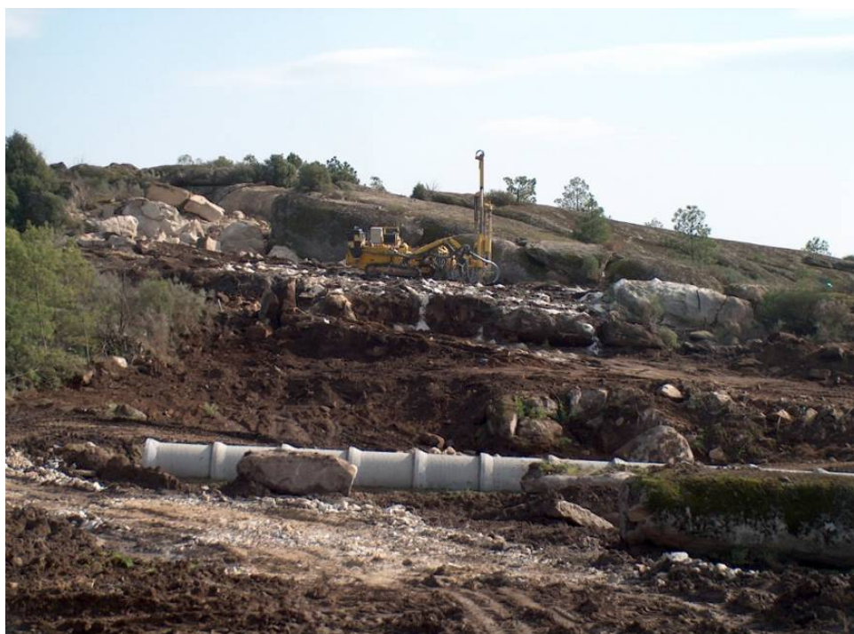
Figura 65 – Obra Valpaços - Zona de trabalho.
