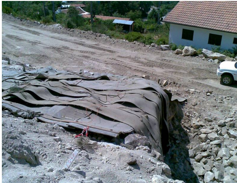
Figura 20 – Variante de Cambarinho: exemplo de desmonte condicionado.
