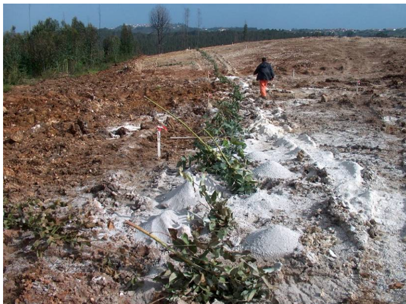
Figura 15 – Alinhamento de furos de pré-corte com grande extensão, definido pelos ramos que servem de tamponamento.
