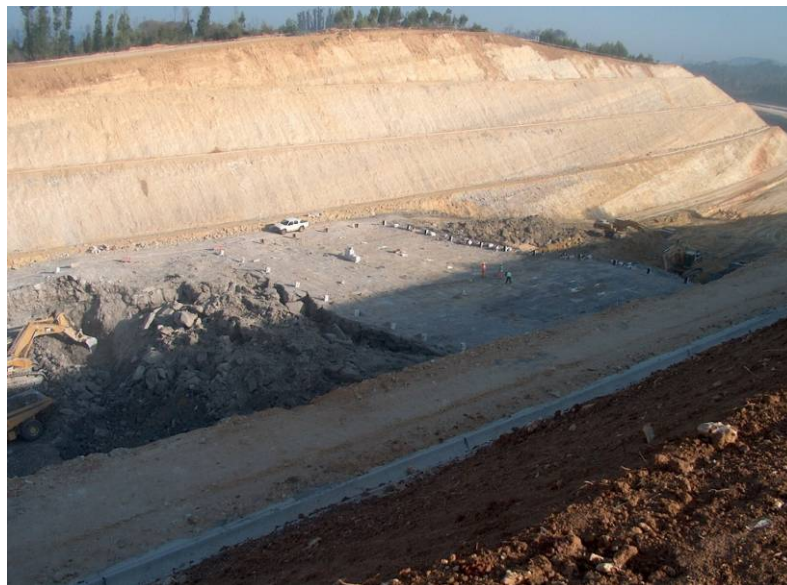
Figura 62 – A17 - Fase de execução de obra.
