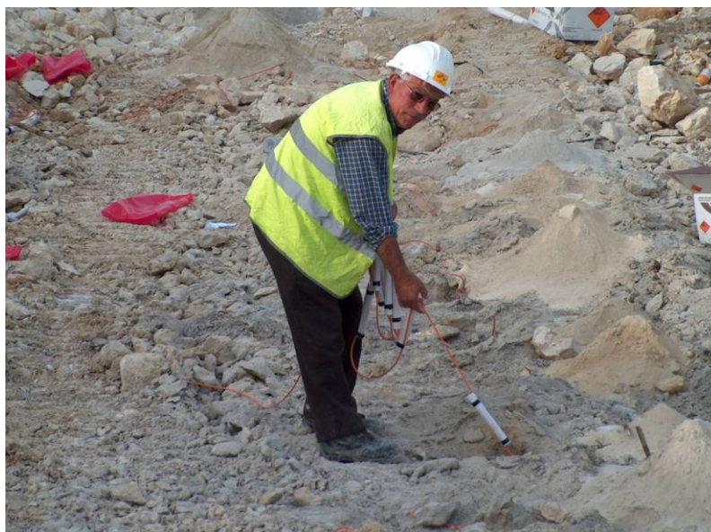
Figura 16 – Aplicação da carga no furo.
