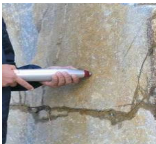
Figura 68 – Martelo de Schmidt: exemplo de execução de ensaio.
