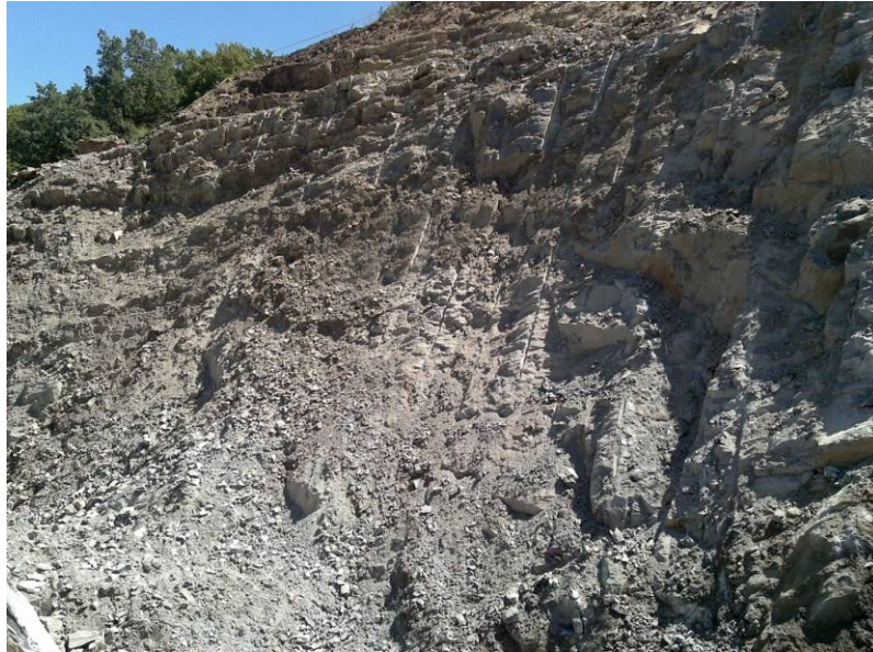
Figura 77 – Plano de pré-corte com sobre-escavação localizada (Tondela).
