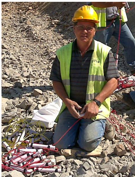
Figura 19 – Construção da carga de coluna.
