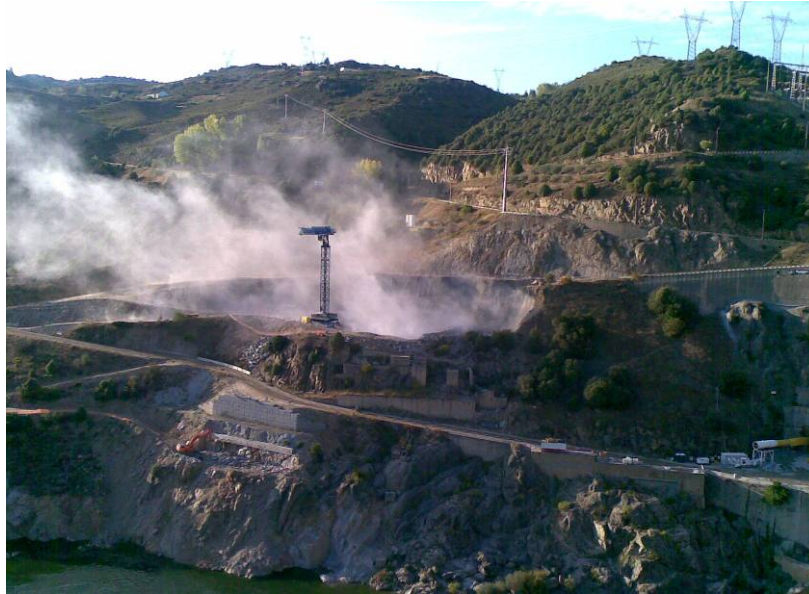
Figura 3 – Barragem da Bemposta.
