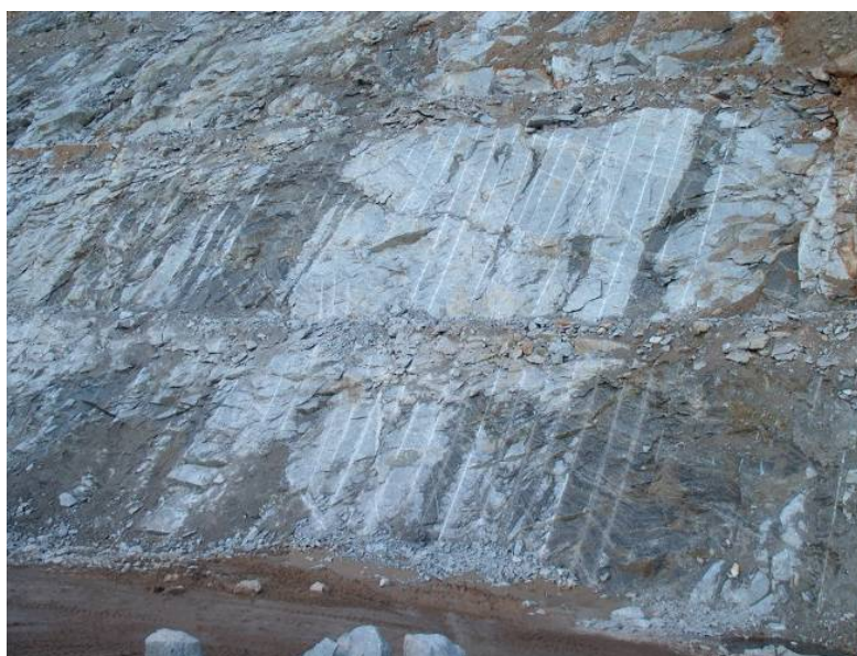
Figura 61 – Pré-corte – furos.
