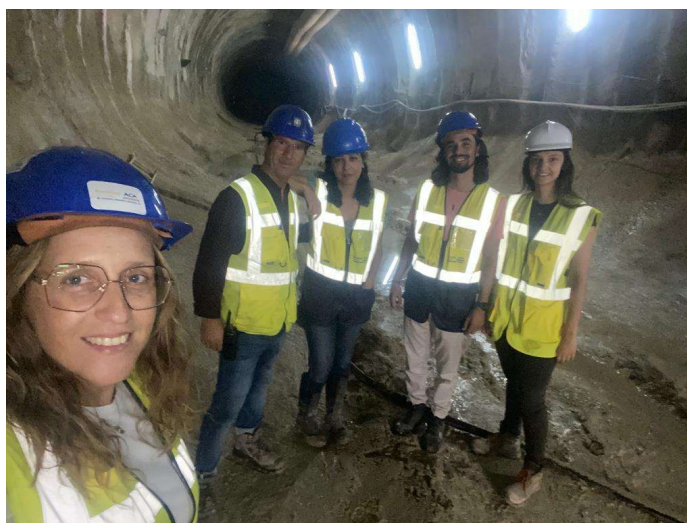
Figura 13 - Equipa da qualidade responsável por garantir a qualidade de execução por parte do empreiteiro (FERROVIAL/ACA)
