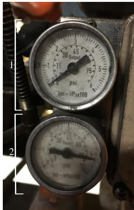
Figura 4.8 - Correto funcionamento das válvulas de controlo pneumático com posicionador durante o aquecimento da corrente (1 - Pressão de saída; 2 - Pressão de entrada).
