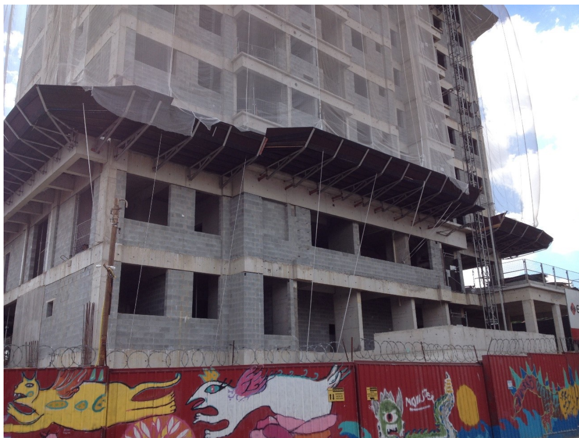
Figura 3.10 – Foto tirada em meados de Março do Empreendimento Charme da Villa.
