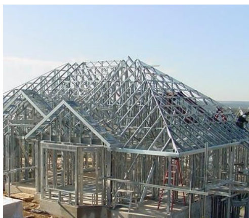
Figura 7 – Construção em light gauge steel framing [27]
