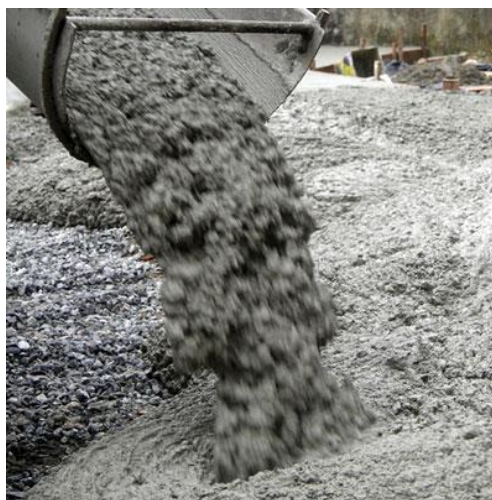
Figura 6 – Construção em betão leve de agregados de argila expandida [26]
