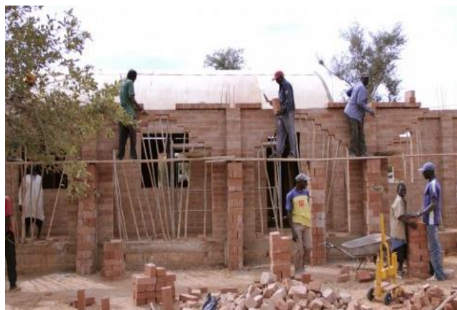
Figura 4 – Construção em bloco de terra comprimido [24]
