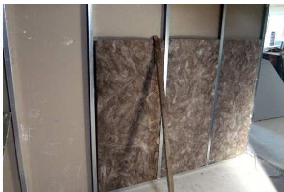
Figura 28 – Execução de contra fachada pelo interior [20]
