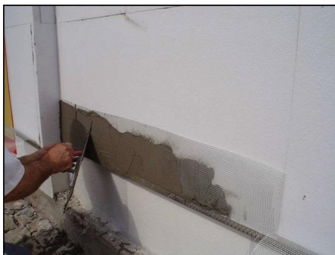
Figura 23 – Pormenor colocação da rede fibra de vidro [31]
