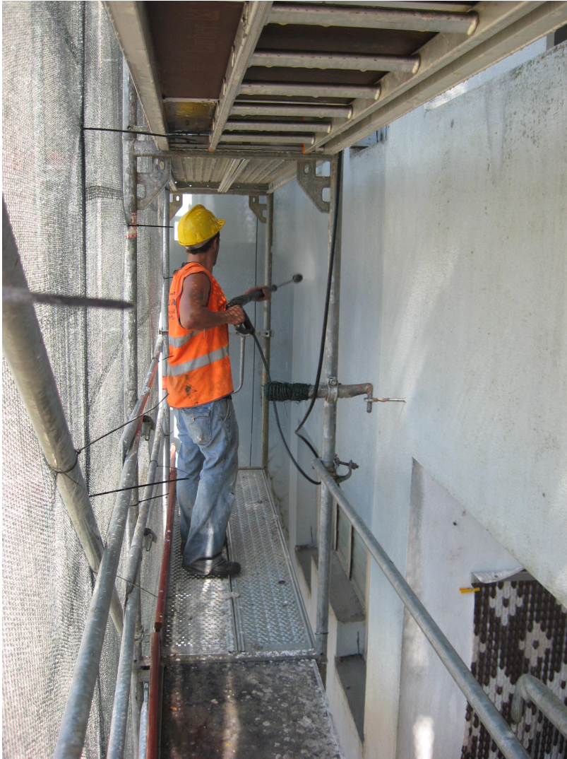
Figura 17 - Lavagem com jacto de água a alta pressão, das superfícies dos edifícios de Vila d'Este
