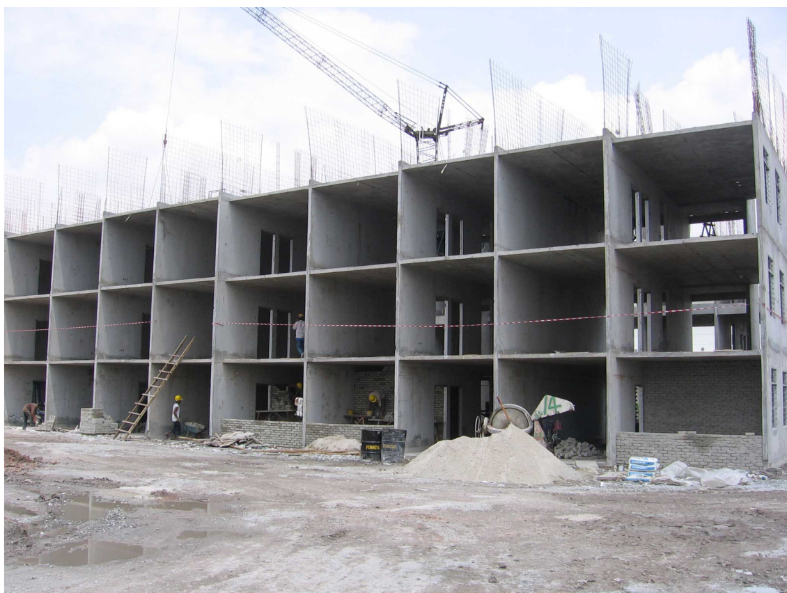
Figura 7 – Exemplo de uma construção com o sistema de cofragem túnel
