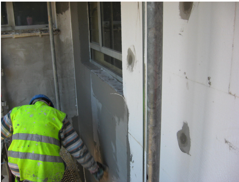
Figura 27 - Aplicação da camada de base armada.
