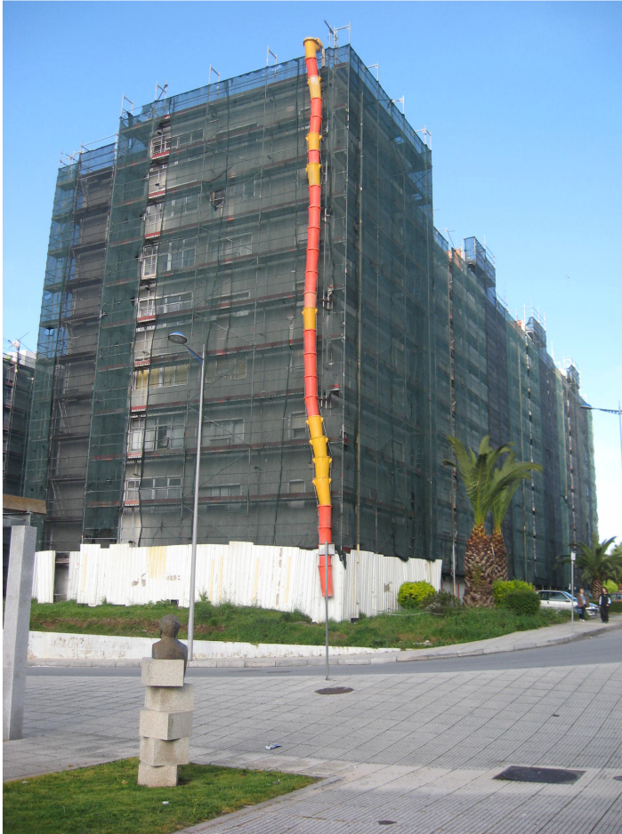
Figura 18 - Foto do andaime de plataforma, fixo, montado no bloco 9, da urbanização de Vila d'Este.
