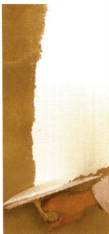
Figura 30 - Aplicação da camada de revestimento final (brochura Viero)
