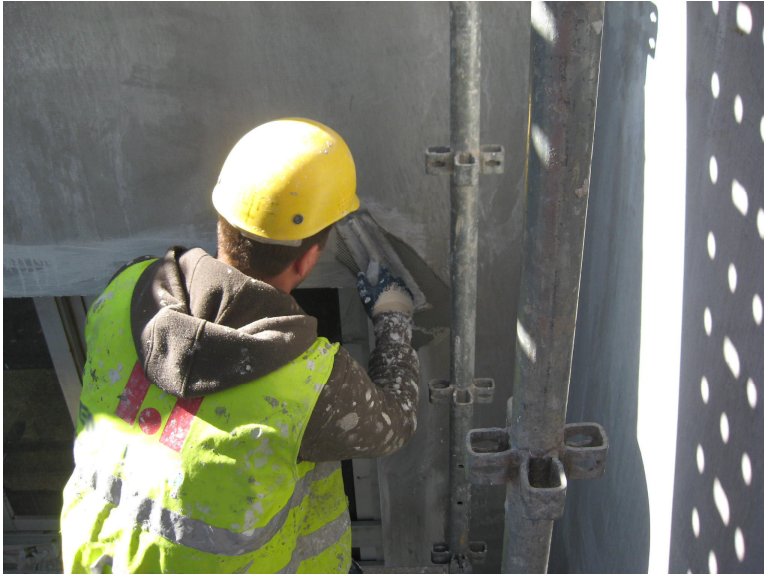
Figura 28 - Aplicação do reforço de um canto do vão da janela
