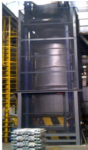
Figura 19 - Novo elevador de carga implementado na unidade de fundição.
